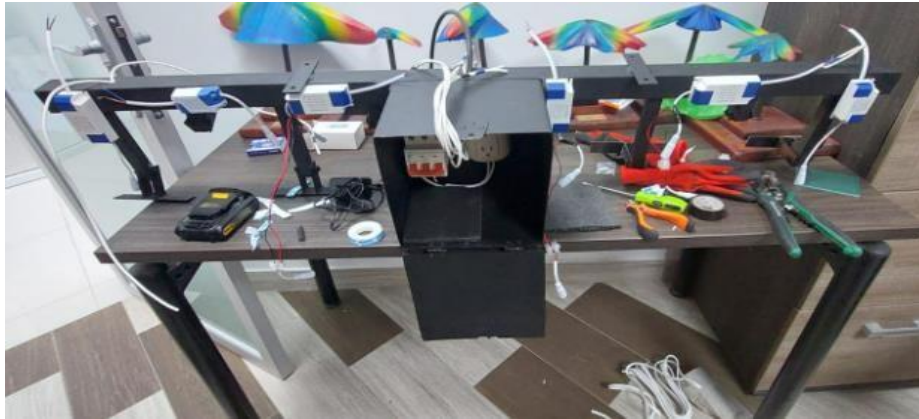
Figura 69. Cableado de la estructura lumínica.
