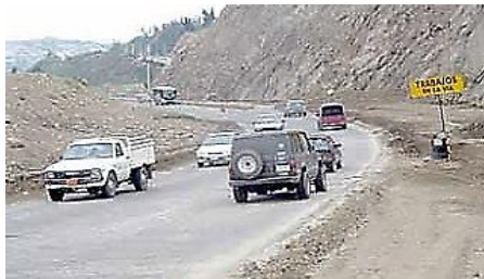
Figura 13: Construcción de la autopista Cuenca–Azogues. Piedra J. [Fotografía]. Azogues, Ecuador.
