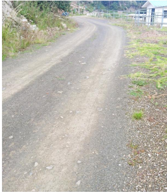
Figura 105: Infraestructura vial de Bellavista. Ochoa, J. (2016). [Fotografía]. Azogues, Ecuador.
