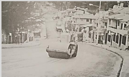
Figura 12: Proceso de pavimentación. Serrano S. (1996). [Fotografía]. Azogues, Ecuador.
