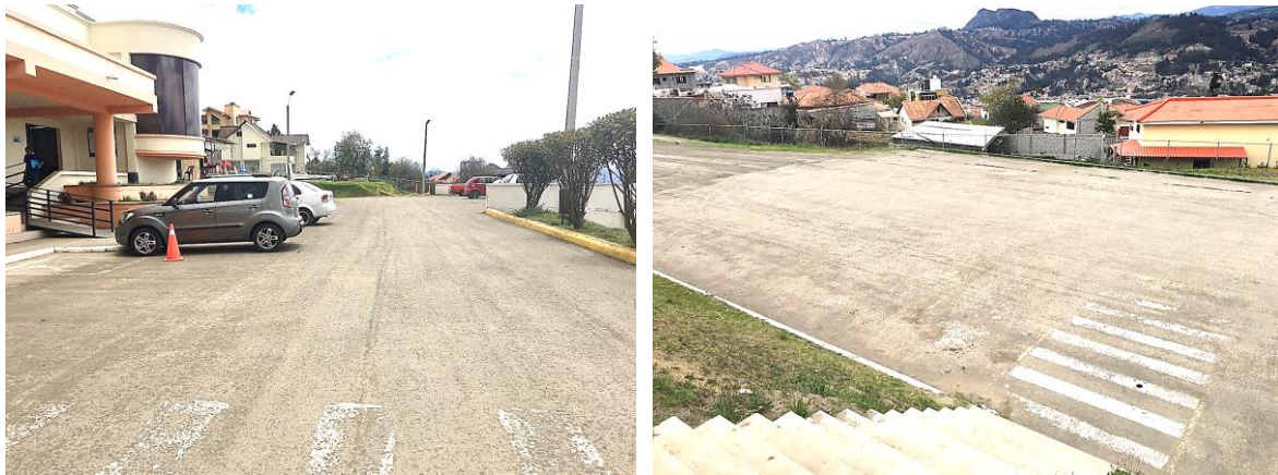
Figura 37: Parqueaderos del Centro de Movilidad. Ochoa, J. (2017). [Fotografía]. Azogues, Ecuador.
