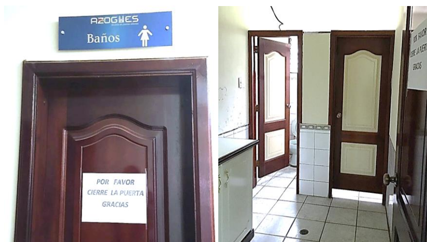
Figura 34: Baterías Sanitarias del Centro de Movilidad. Ochoa, J. (2017). [Fotografía]. Azogues, Ecuador.
