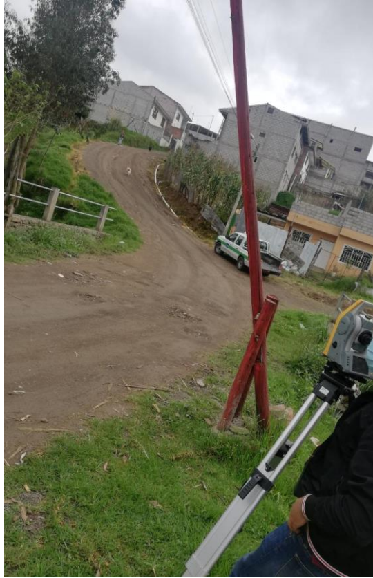
Figura 9. Levantamiento topográfico en la zona de estudio
