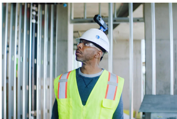
Figura 10: :Aplicación de OpenSpace en obra.
