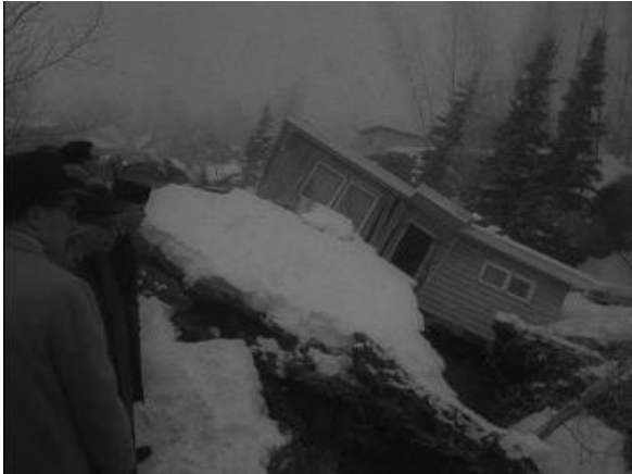
Foto 5: Estado de viviendas de menor escala durante el terremoto de Alaska en 1964.
