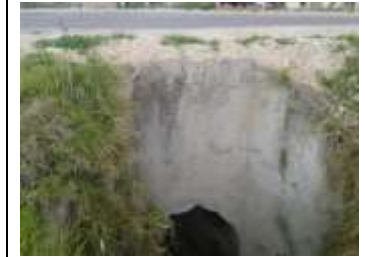
Foto N°24 Acumulación de sedimentos en el río.
