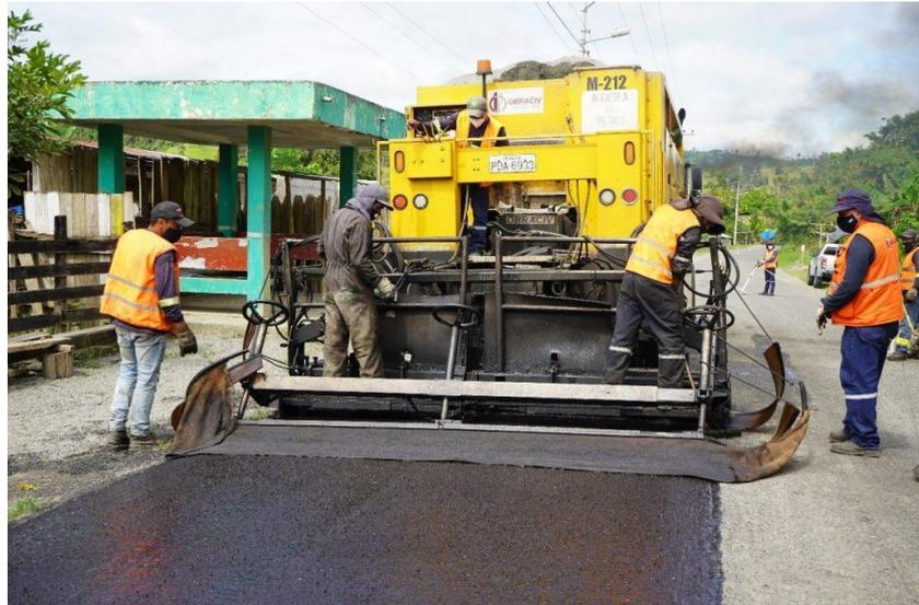
**Ilustración 1.** Colocación del micropavimento en la vía Palestina-Chontaduro cantón Rio Verde.
