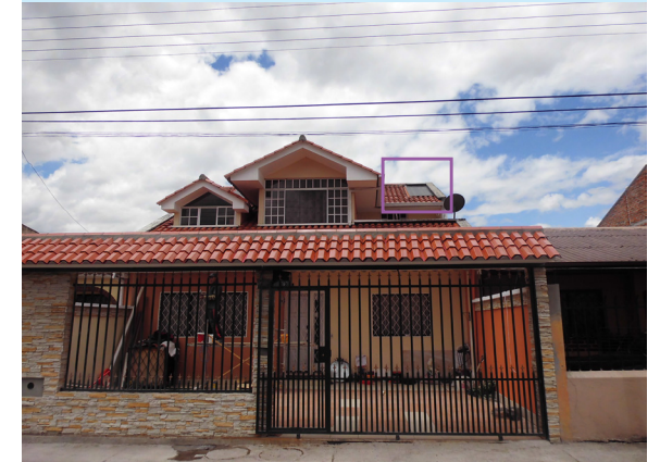
FOTO #45 VIVIENDA UNIFAMILIAR CON CUBIERTAS TRANSLUCIDAS DE VIDRIO, MATERIAL PLÁSTICO O ACRÍLICO
