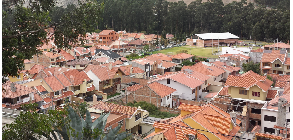
FOTO #25 CUBIERTAS DE VIVIENDAS EN CDLA. DE LOS INGENIEROS
