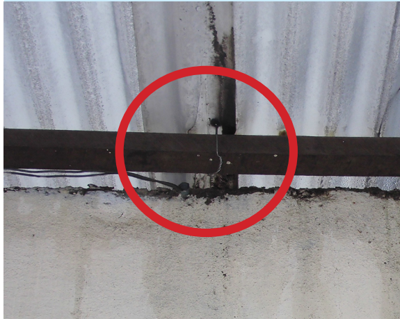
FOTO #44 SUJECIÓN EMPÍRICA, CON ALAMBRE DE GALVANIZADO Y CAPUCHÓN.
