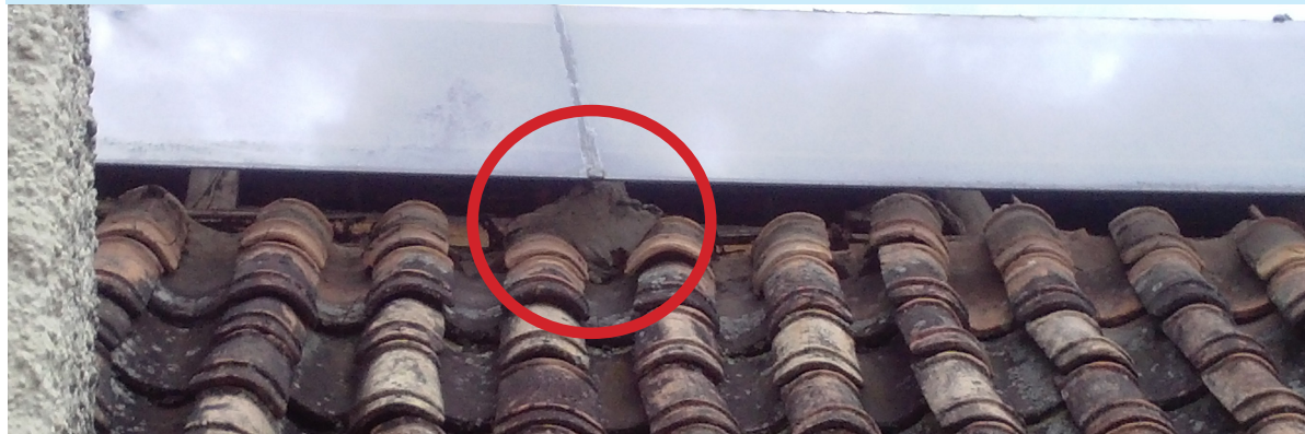
FOTO #40 ESTRUCTURA EMPÍRICA PARA CUBIERTA DE VIDRIO
