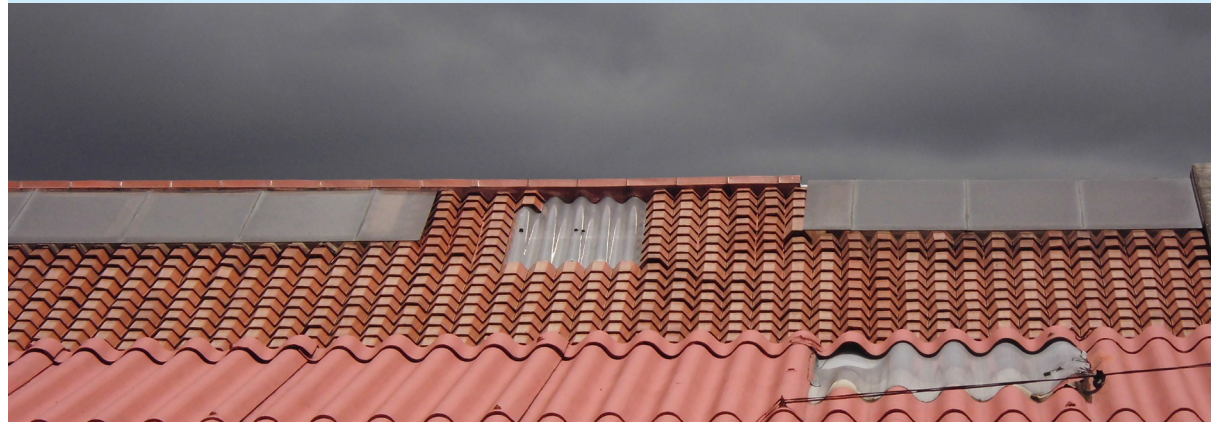
FOTO #46 VIVIENDA UNIFAMILIAR CON CUBIERTAS TRANSLUCIDAS DE VIDRIO, MATERIAL PLÁSTICO O ACRÍLICO, DESDE FACHADA POSTERIOR
