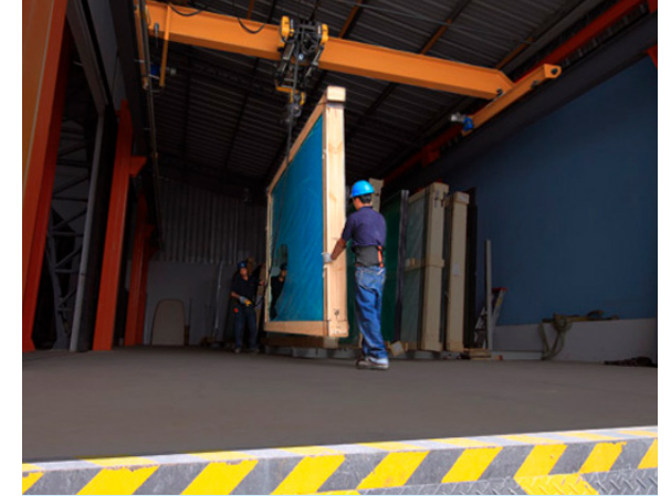
FOTO #19 TRANSPORTE DE PLANCHAS DE VIDRIO TEMPLADO
