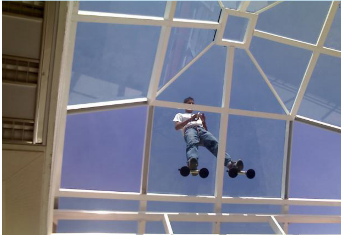
FOTO #12 EJEMPLO DE RESISTENCIA DEL VIDRIO TEMPLADO
