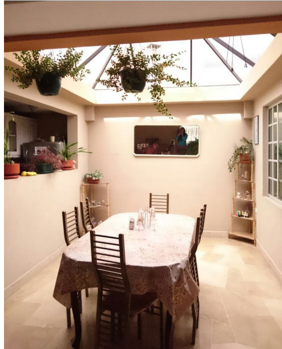
FOTO #8 CUBIERTA DE VIDRIO SOBRE COMEDOR
