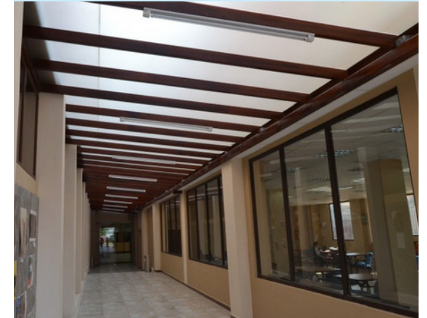
FOTO #9 CUBIERTA DE POLICARBONATO, BIBLIOTECA UPS.
