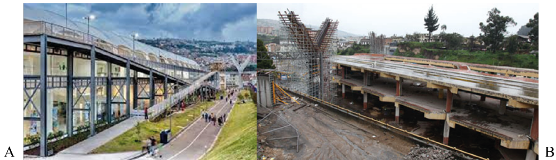
Figura 1.63: Sistema constructivo aplicado al Parque Urbano.
