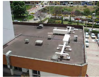
(c) Cubierta de fibrocemento
