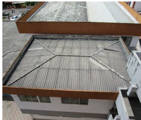
FIGURA 2.38: Cubierta Bloque B
