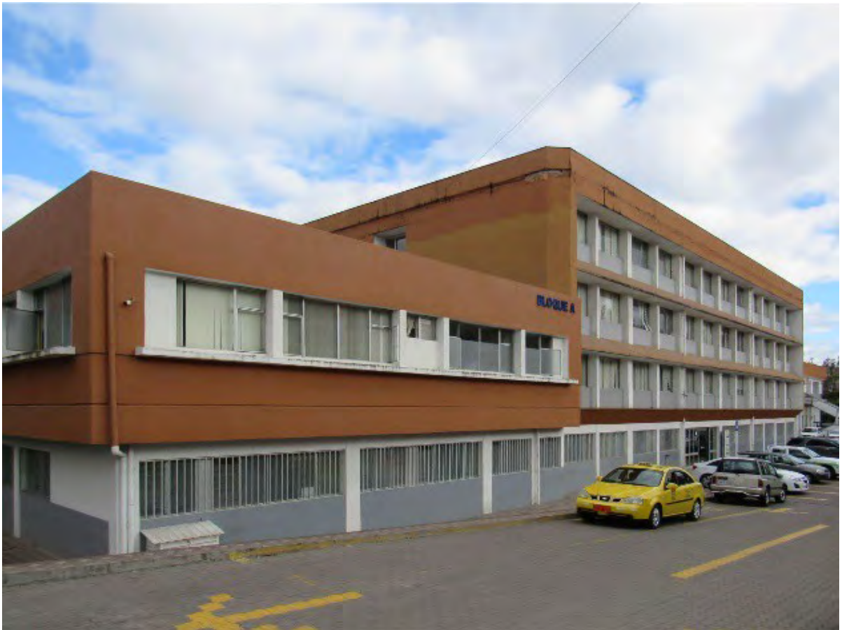
FIGURA 1.6: Fachada principal – Bloque A
