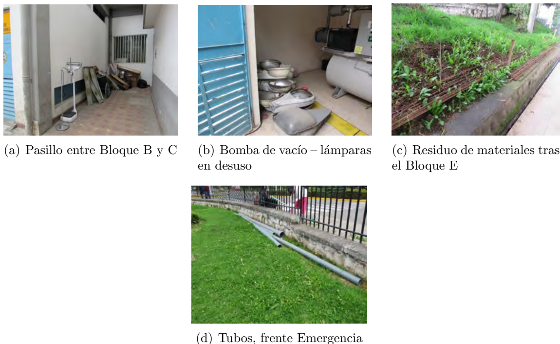
FIGURA 2.56: Acumulación de materiales
