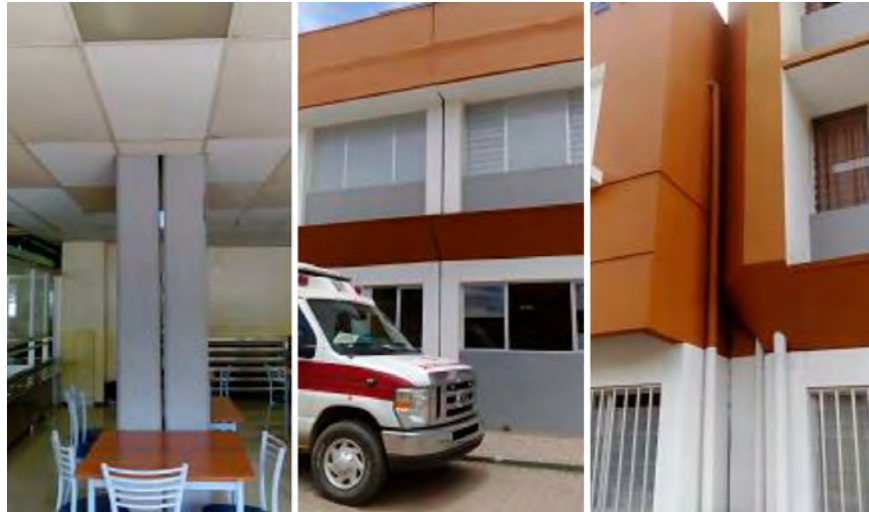
FIGURA 2.58: Continuidad y discontinuidad de juntas constructivas
