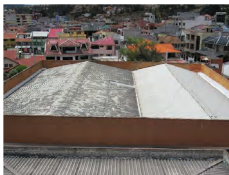
(b) Cubierta Bloque C
