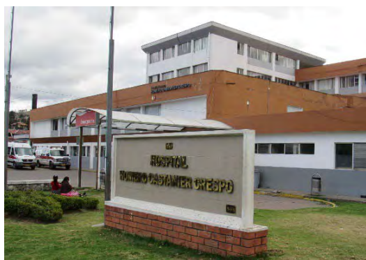
(b) Bloques A, ingreso a emergencia
