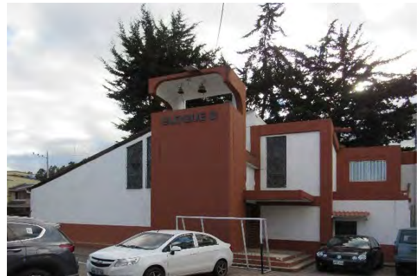
(b) Fachada lateral
