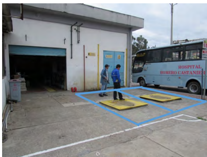
FIGURA 2.20: Tanques de combustible bajo tierra
