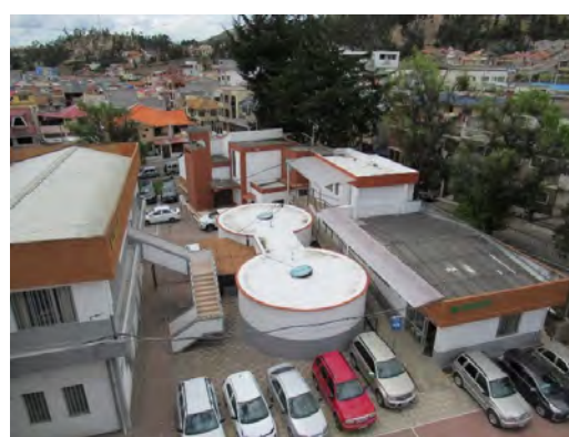
(d) Cubiertas y terraza, Bloque E
