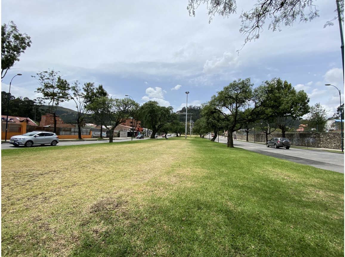
FIGURA 2.56: Estado actual de medianera en intersección con Belisario Andrade. 2020.
