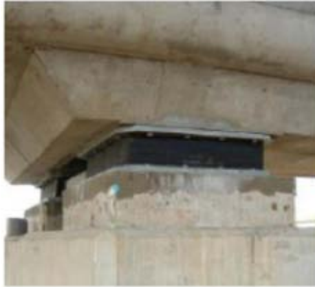
Fig 2. Aislador con Centro de Plomo.
