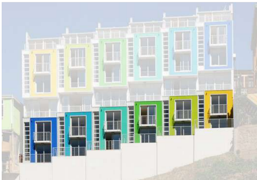
FIGURA 2.6: Ubicación en fachada de lofts de dos niveles // Fuente: (Mendizábal, 2009).
