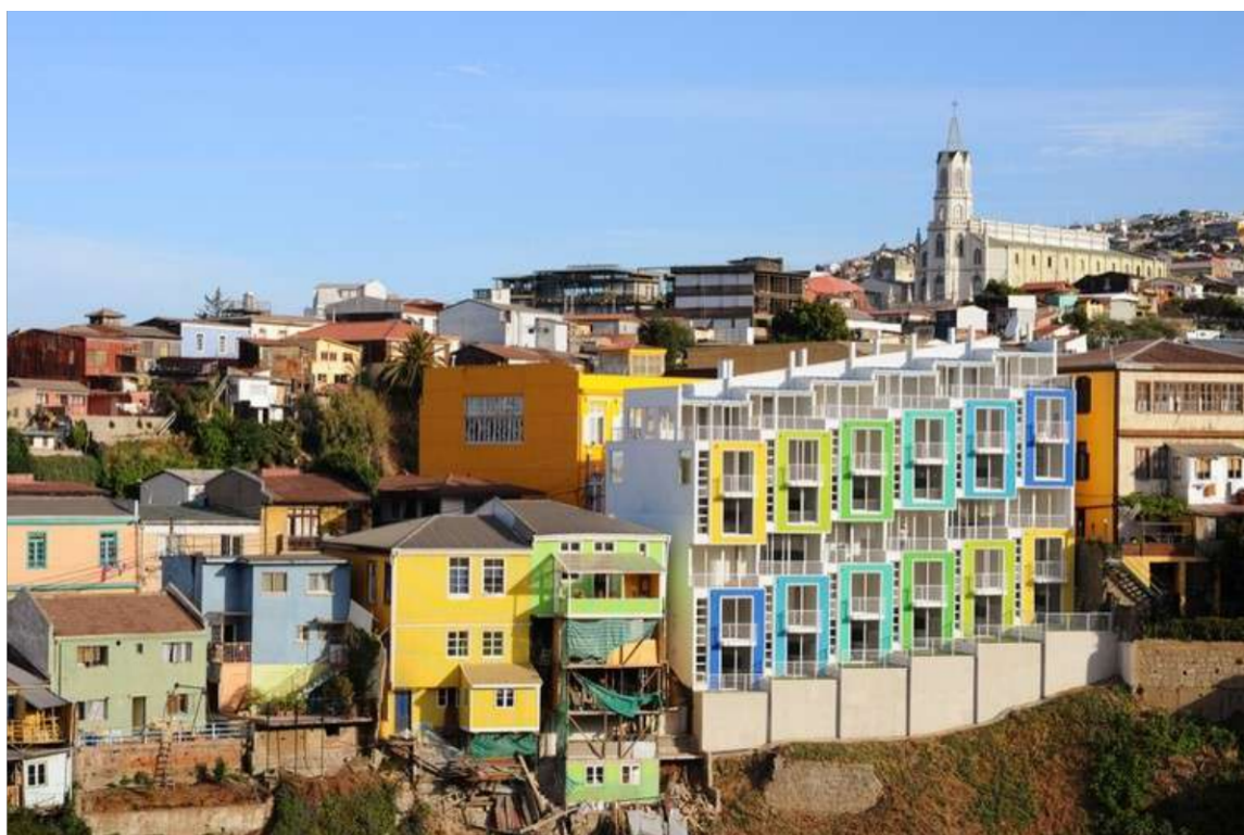
FIGURA 2.11: Integración de la fachada con el barrio // Fuente: (Mendizábal, 2009).
