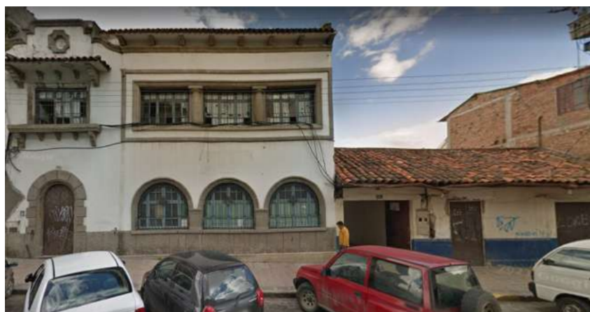
FIGURA 2.52: Estado de la vivienda previo a la intervención. // Fuente: (Earth, 2023).
