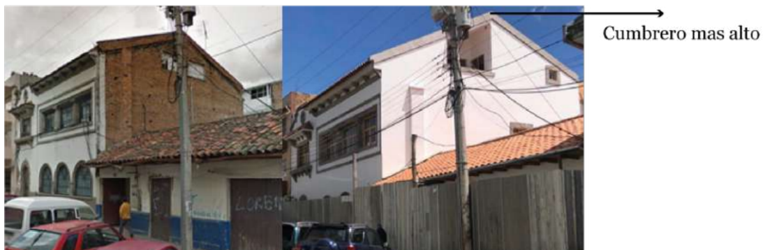
FIGURA 2.55: Modificación en la altura del bloque 1. A) estado previo a la intervención. B) estado actual. // Fuente: (Earth, 2023).
