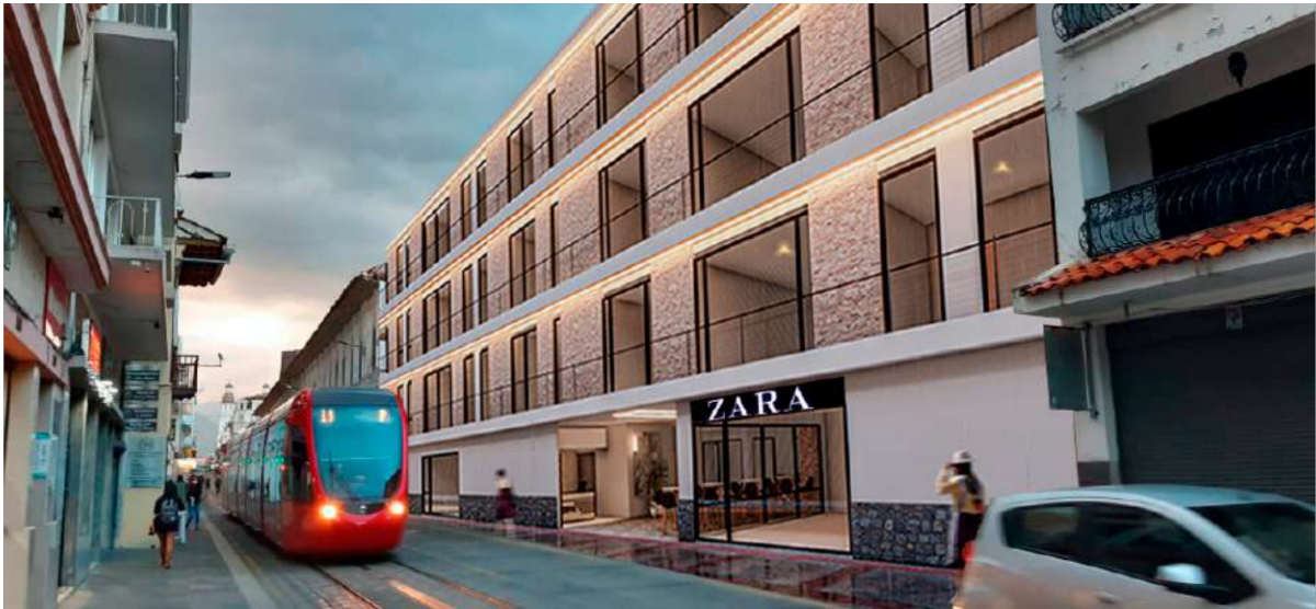
FIGURA 4.29: Fachada hacia la calle Gran Colombia // Fuente: propio // Elaborado: Propia.
