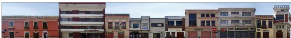
FIGURA 3.67: Tramo Hermano Miguel (frente) // Fuente: Propia // Elaborado: Propio
