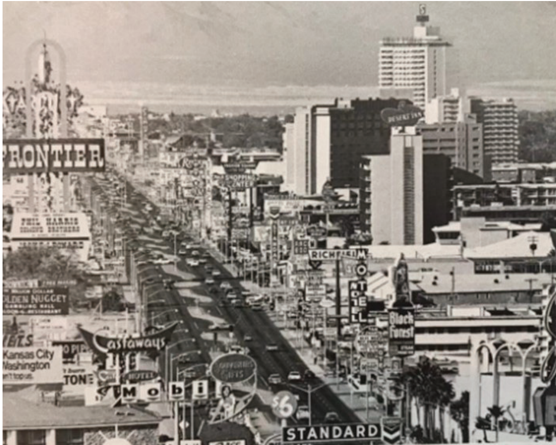
Figura 2.15: El strip (franja) de las Vegas. Descripción: permite visualizar la superposición de edificios, mensajes publicitarios y otros objetos para generar un paisaje urbano cargado de simbolismo (Venturi et al., 1998, pp. 61).
