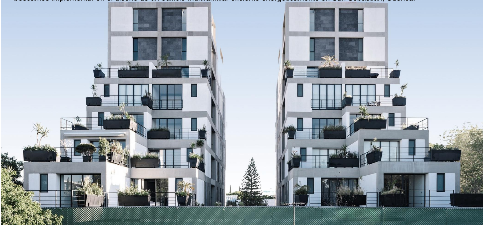
Figura 10: Edificio terrazas Tadeo.
