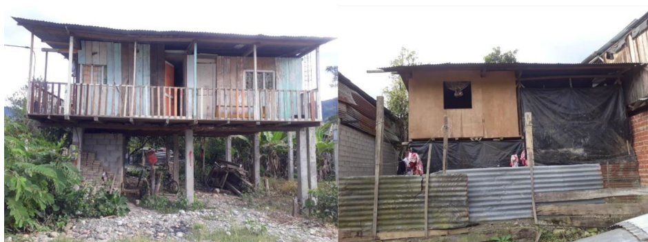
FIGURA 2.24: Viviendas precarias en zona de riesgo.
