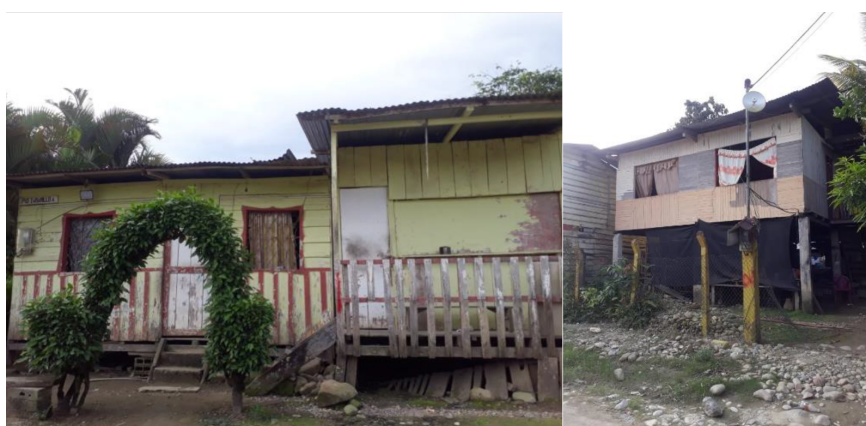
FIGURA 2.25: Viviendas afectadas por inundaciones en Gran Colombia.
