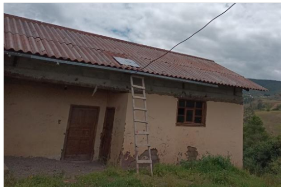
Figura 21 Panel fotovoltaico de 100W. Fuente (Miguel Siguencia, Santiago Salto, Autor).
