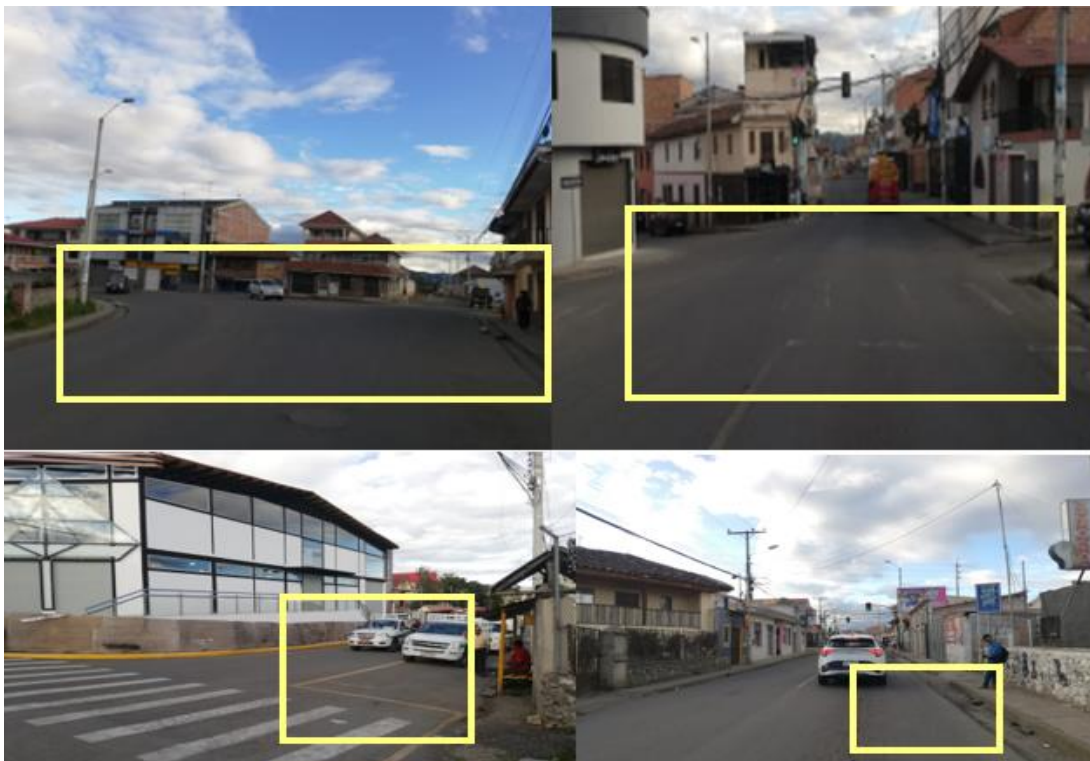
Ilustración 21: Estado de la señalización longitudinal de las vías. Fuente: Autor.
