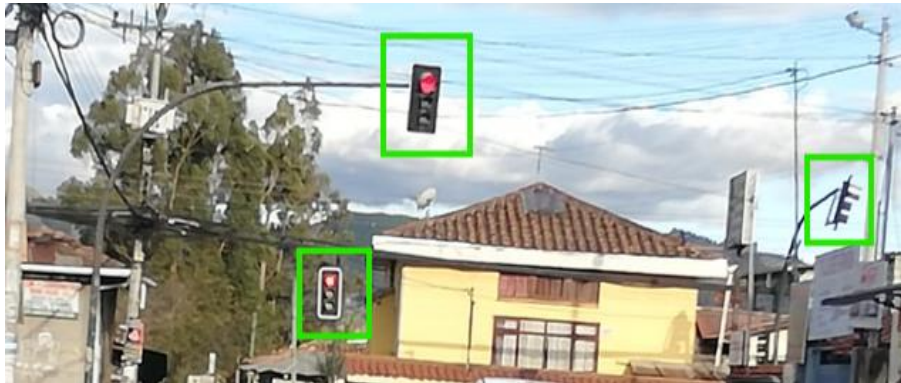
Ilustración 24: Estado de la semaforización vehicular y peatonal (Semaforización peatonal nula). Fuente: Autor.
