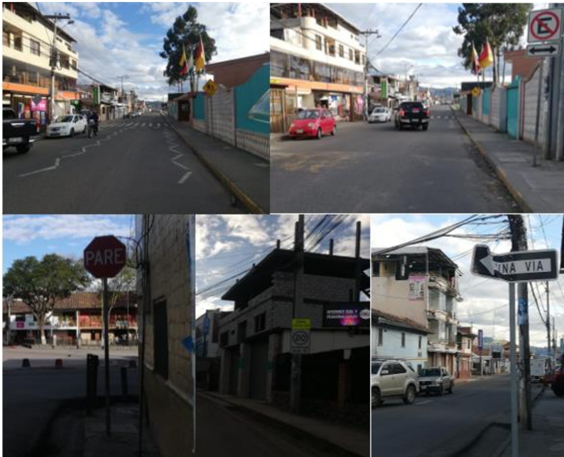
Ilustración 23: Estado de la señalización vertical. Fuente: Autor.
