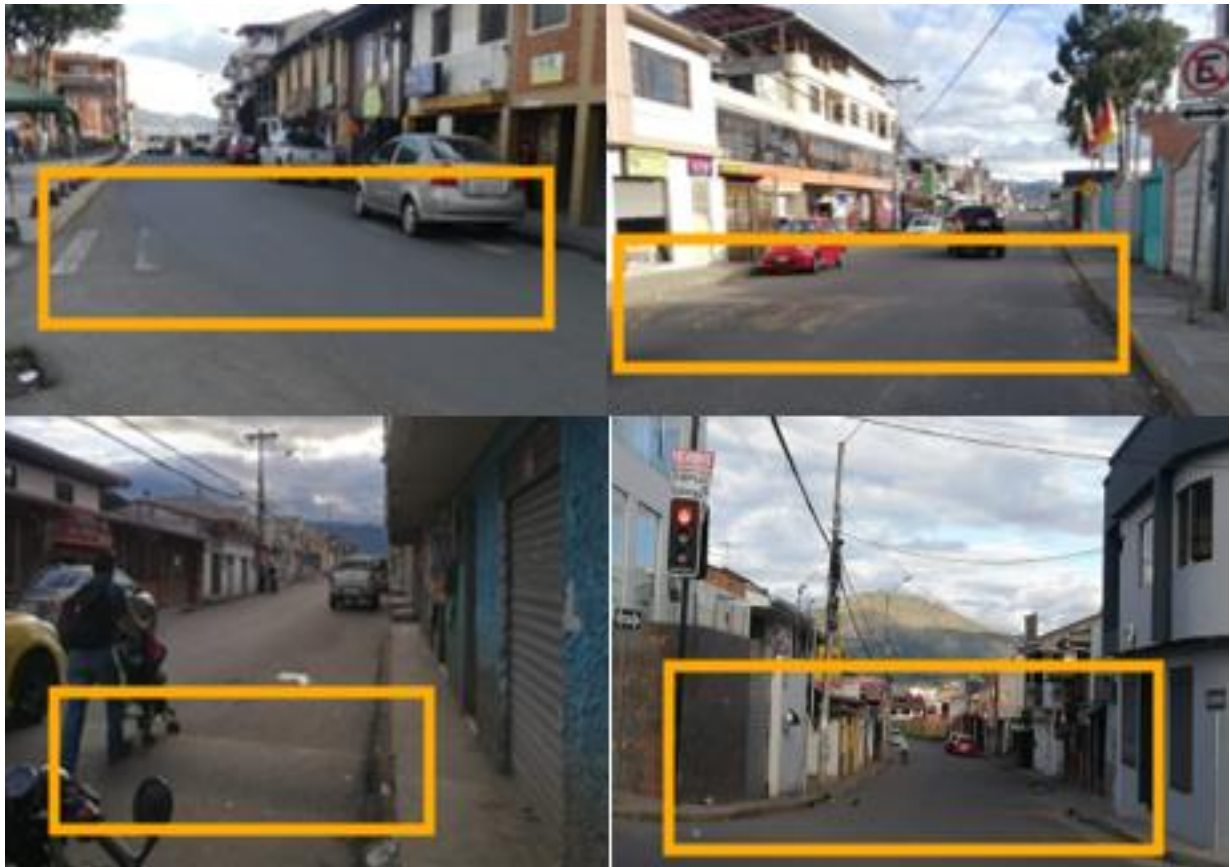
Ilustración 22: Estado del paso cebra y rompe velocidades. Fuente: Autor.
