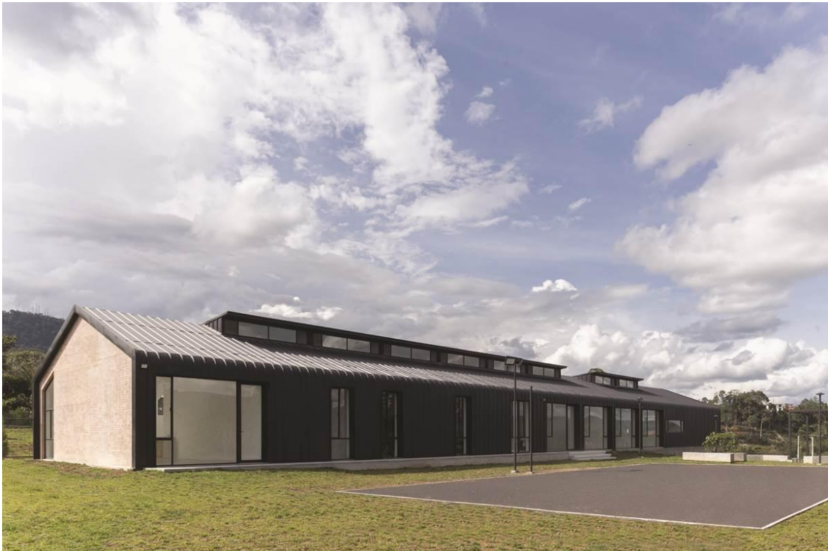
Figura 26: Casa de acogida y comedor comunitario
