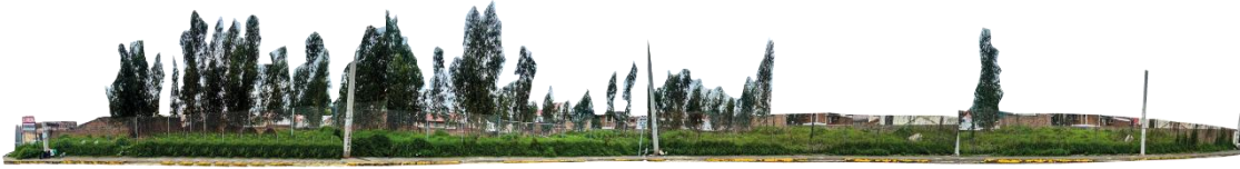
TRAMO 1: CALLE LUIS JARAMILLO
