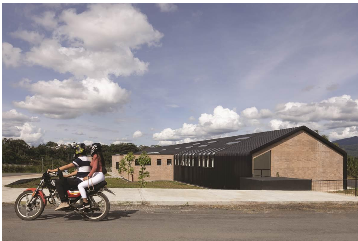
Figura 28: Casa de acogida y comedor comunitario
