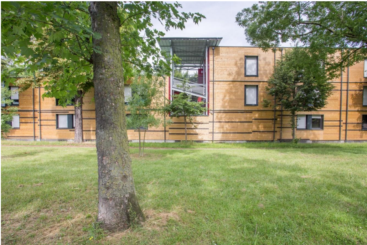
Figura 14: Fachada Lateral Centro de Hospedaje de Emergencia “Promesa al Amanecer”
