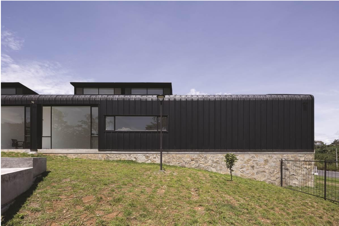
Figura 35: Exterior Casa de Acogida y Comedor Comunitario.
