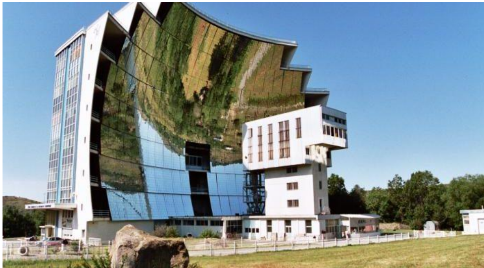
Figura 3 Horno Solar de Odeillo, Fuente: Trombe & Vinh,. (2012),.
