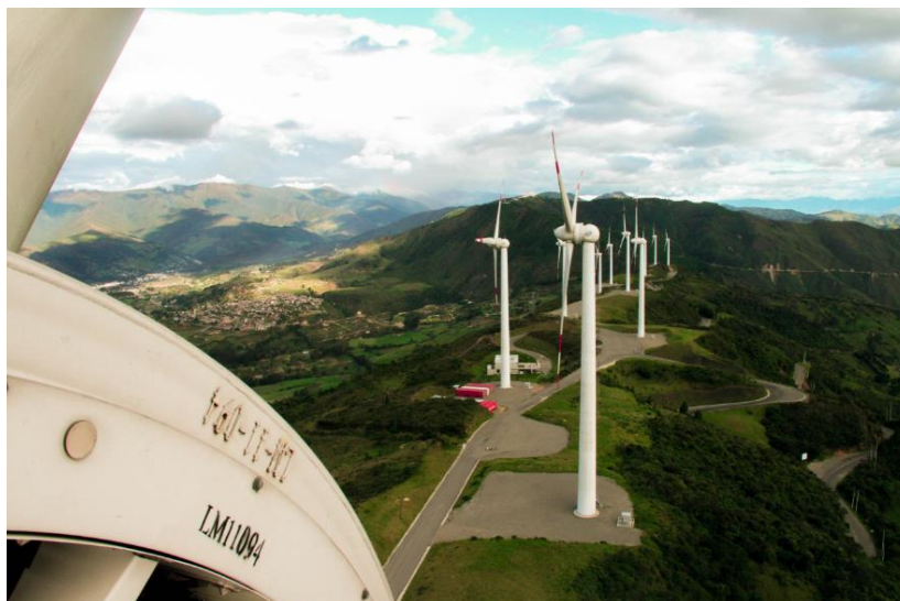
Figura 20. Proyecto eólico Villonaco
