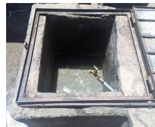
FOTOGRAFÍA 24: Vista del lavador
