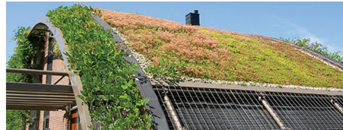
FOTOGRAFÍA 15: Cubierta verde extensiva
