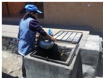
FOTOGRAFÍA 23: Vista del lavador
