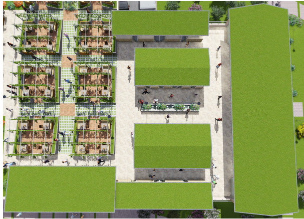
FIGURA 18: Cubierta extensiva de la propuesta
