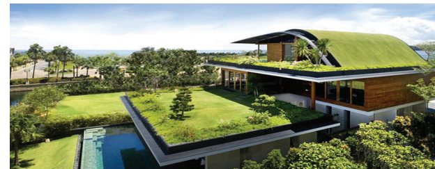
FOTOGRAFÍA 16: Cubierta verde semi-intensiva
