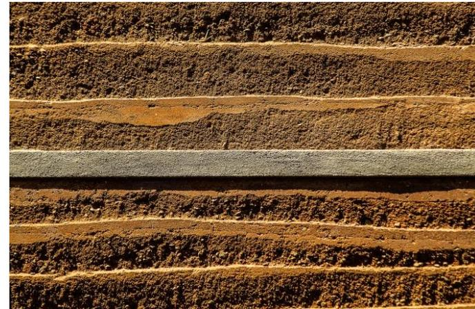
**Ilustración 78 Composición del Muro de Tapial.**
