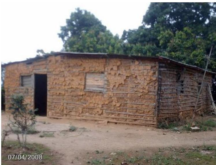
**Ilustración 80 Vivienda con muros de bahareque.**
