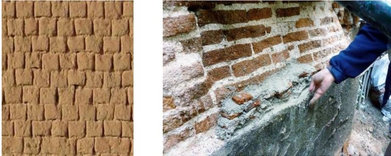
**Ilustración 110 Muro de Adobe y Muro de Cal y Ladrillo de Obra.**
