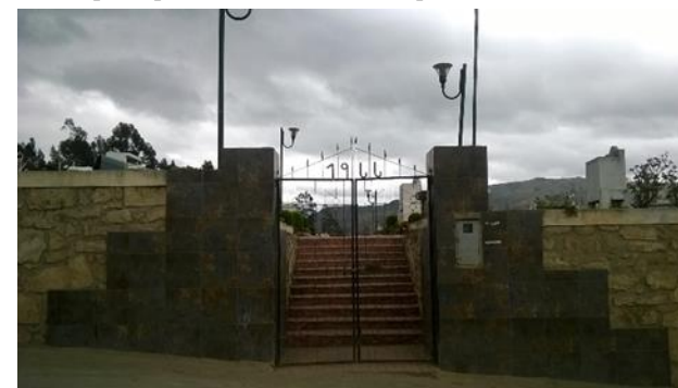
Fotografía N° 16 Puerta principal del cementerio Parroquial San Luis de Cumbe
