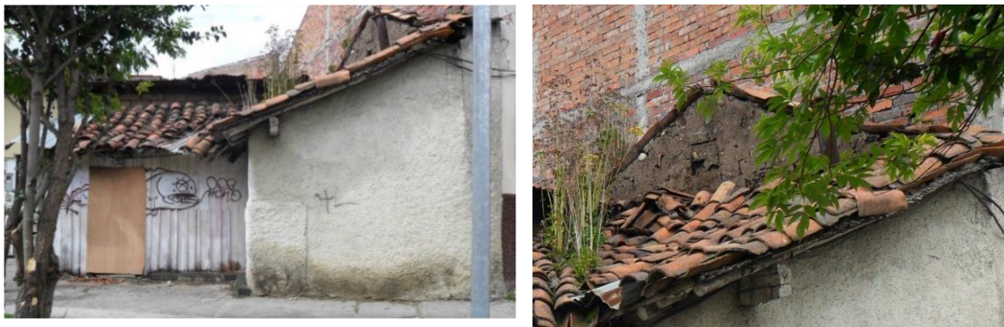
Fotografía N.13: Fachada y Cubierta en 2014. Fuente; Iturralde, 2014.
