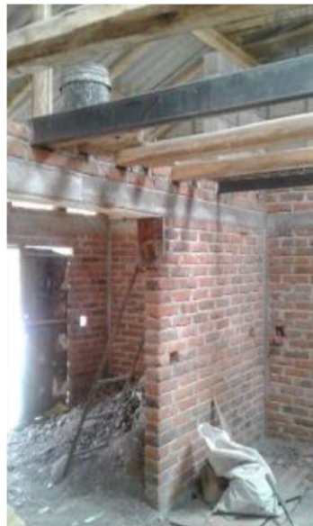
Fotografía 15: Mampostería de ladrillo y bloque. Estructura de madera y acero. Fuente; el autor.
