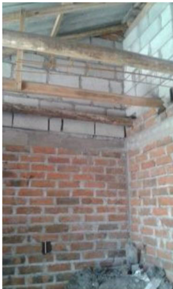
Fotografía 15: Mampostería de ladrillo y bloque. Estructura de madera y acero. Fuente; el autor.
