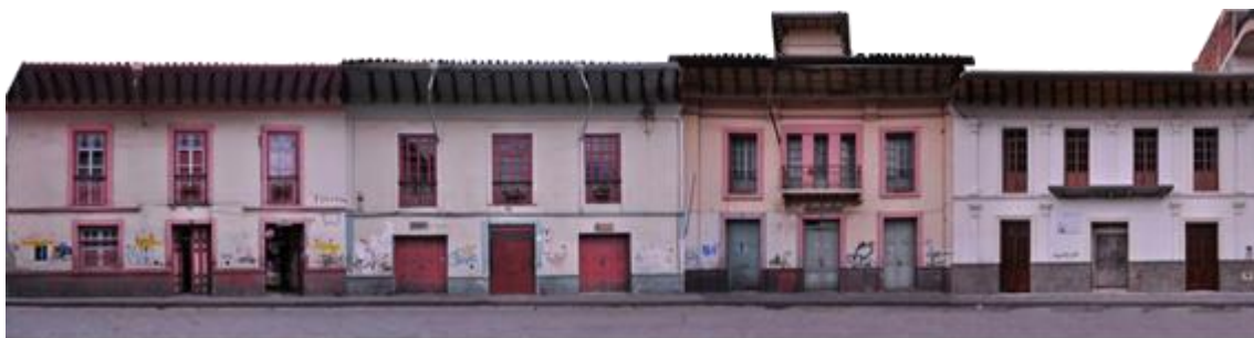
Imagen N.4: Levantamiento de tramo, Calle Larga. Fuente; Pacurucu, 2015.
