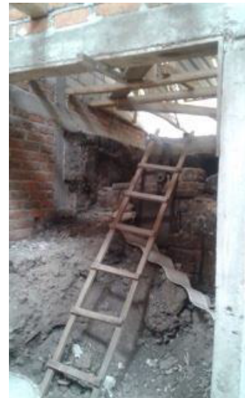
Fotografía 15: Mampostería de ladrillo y bloque. Estructura de madera y acero. Fuente; el autor.
