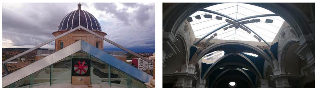
Fotografía N.10: Cúpula vista exterior e interior después de la intervención. Fuente; Matoses, 2017.
