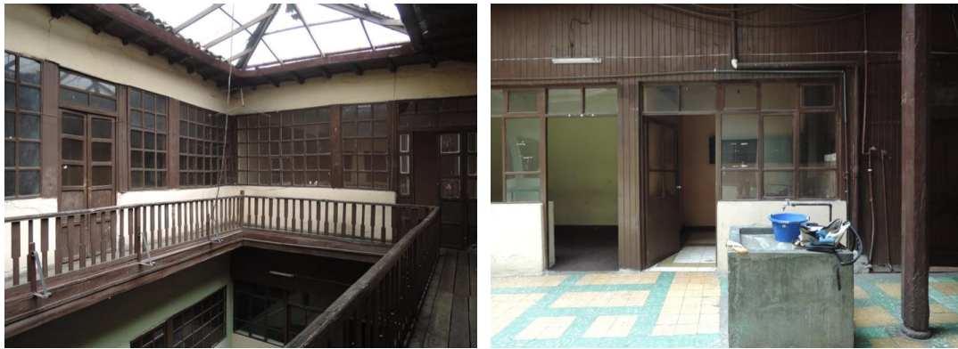
Fotografía N.11: Vista interior de planta alta y planta baja. Fuente; Pacurucu, 2015.
