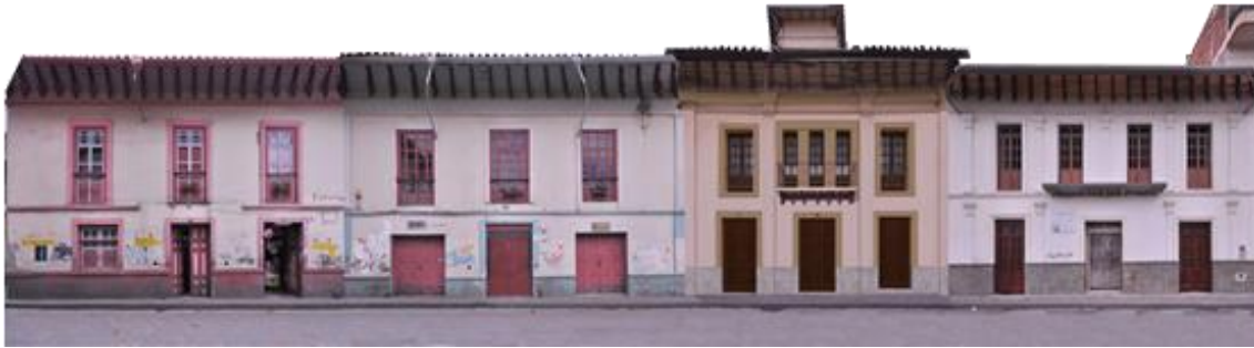
Imagen N.5: Levantamiento de tramo, Calle Larga. Intervención al inmueble. Fuente; Pacurucu, 2015.
