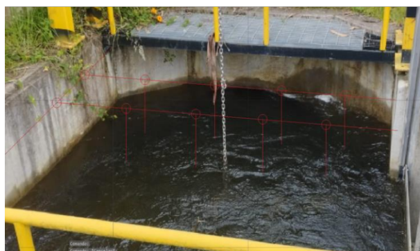
Gráfica 8: Seccionamiento de aforo en la bocatoma.
