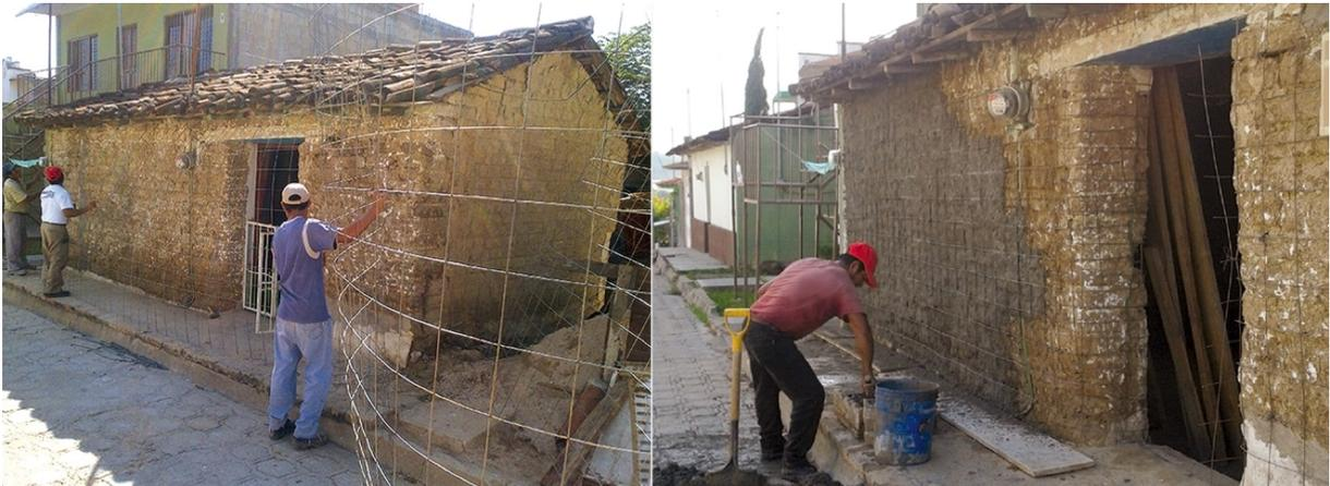
FIGURA 3.14: Refuerzo de muros de adobe con malla electrosoldada
