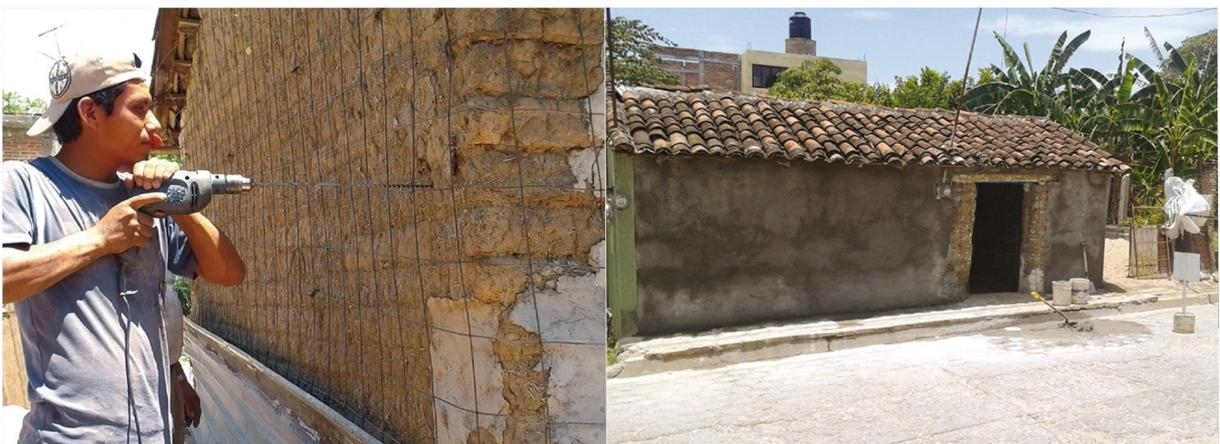
FIGURA 3.15: Perforación y colocación de la malla electrosoldada
