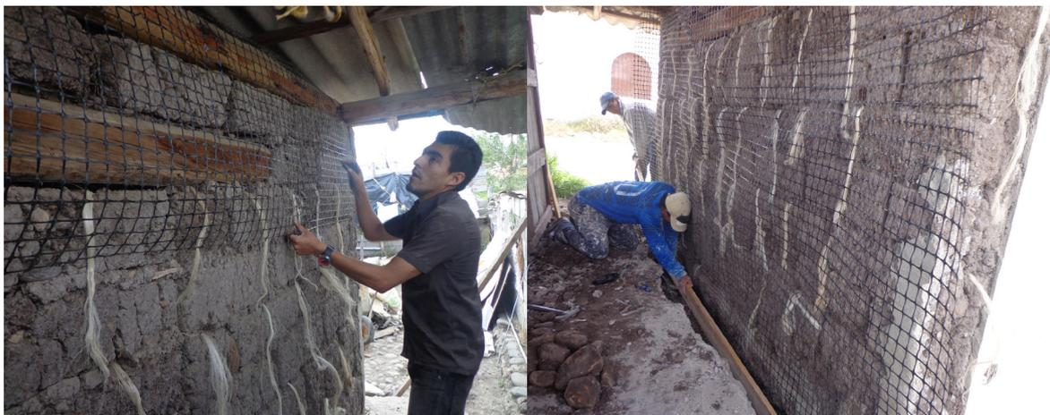
FIGURA 3.10: Colocado de geomalla / refuerzo de la base del muro
