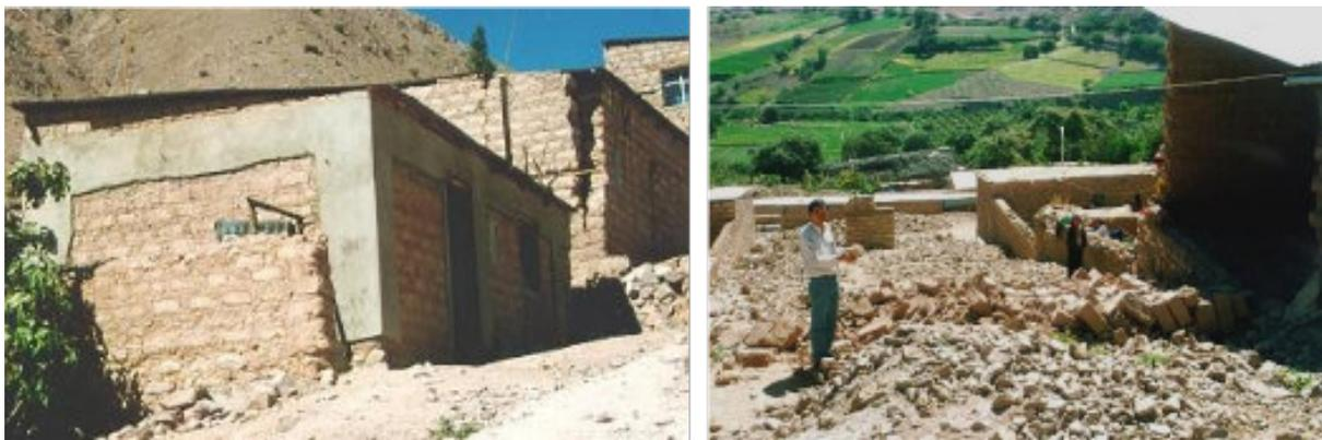
FIGURA 1.6: Vivienda reforzada / Vivienda colapsada durante un sismo.
