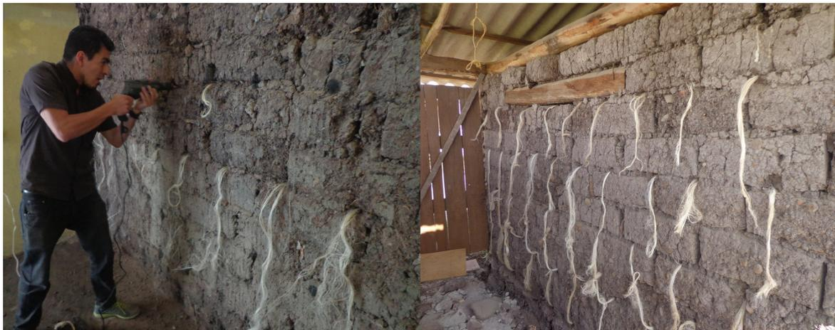
FIGURA 3.9: Perforación del muro/ Conectores de cabuya
