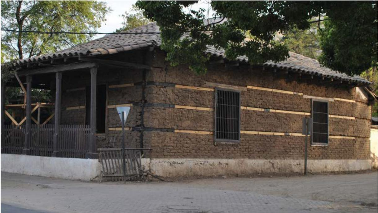
FIGURA 3.13: Refuerzo horizontal con elementos de madera tipo escalerilla
