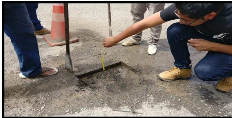
Figura 34: Corte del Pavimento.
