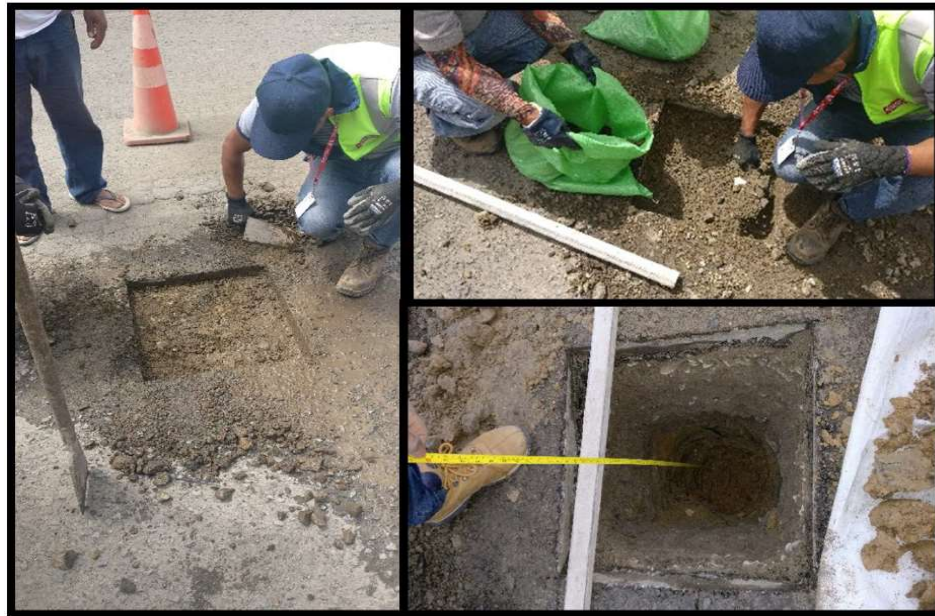
Figura 35: Procedimiento De Extracción de Calicatas.
