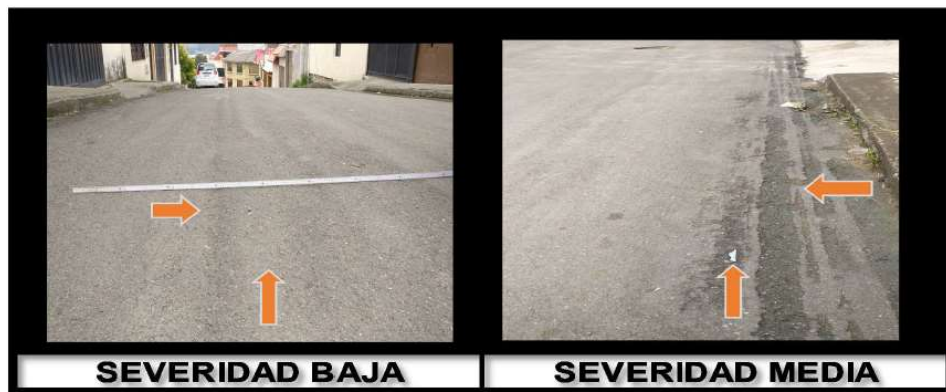
Figura 30: Ahuellamiento.
