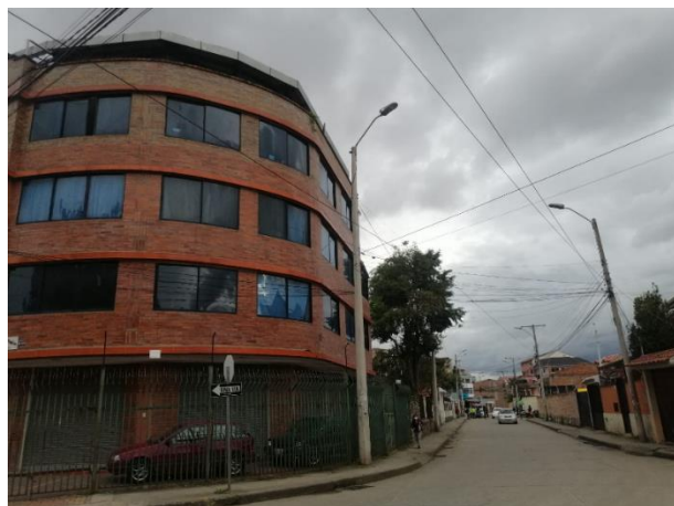
Ilustración 46 Recorrido sector Puertas del Sol
