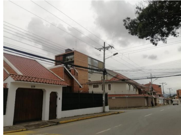
Ilustración 53 Recorrido sector Puertas del Sol
