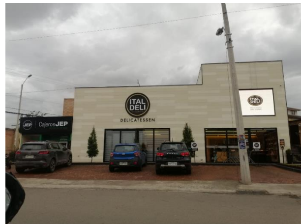
Ilustración 57 Recorrido sector Puertas del Sol
