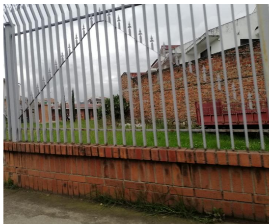
Ilustración 48 Recorrido sector Puertas del Sol
