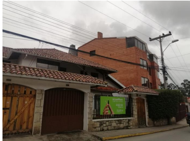
Ilustración 49 Recorrido sector Puertas del Sol
