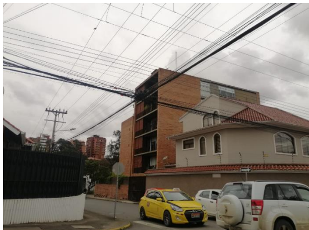
Ilustración 51 Recorrido sector Puertas del Sol
