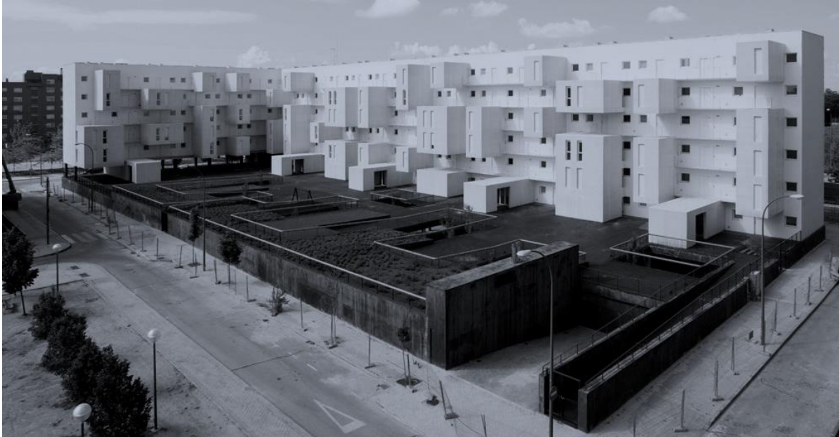
Figura 18: 102 viviendas de Carabanchel
