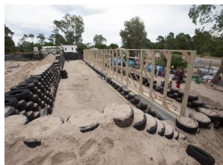
Ilustración 5.- Taludes hechos con llantas recicladas
