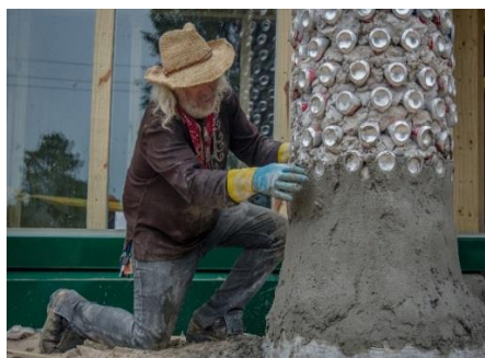
Ilustración 3.- Muros con latas y tierra
