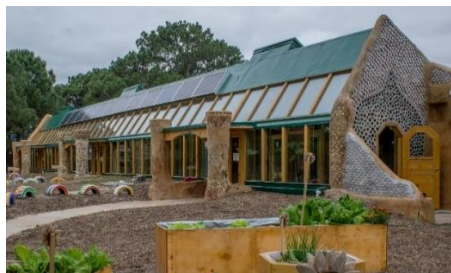
Ilustración 2.- Vista general de la escuela
