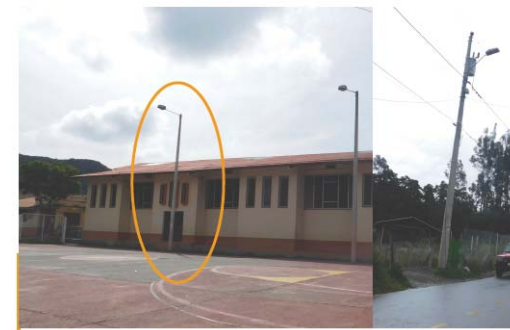
Postes de alumbrado público
