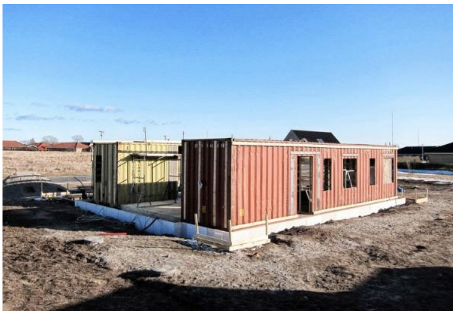
Figura 70: Proceso de construcción de viviendas en contenedores
