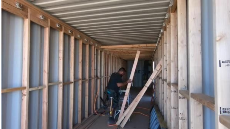
Figura 81: Armado de estructura interior
