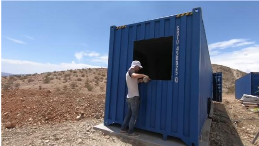
Figura 79: Aperturas de vanos para ventanas
