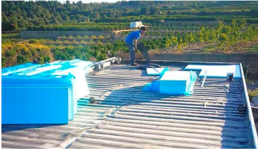
Figura 75: Acondicionamiento de cubierta
