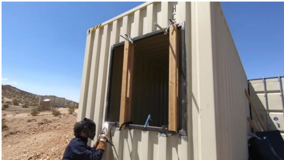
Figura 80: Colocación de carpintería
