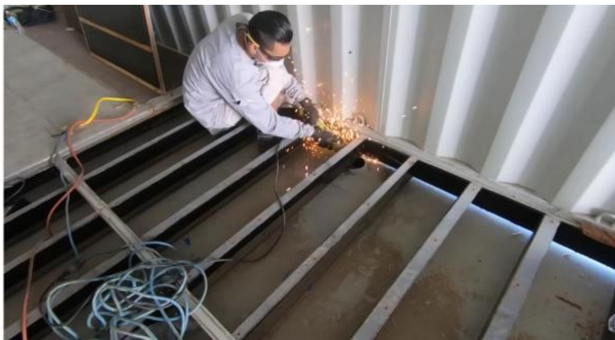
Figura 85: Estructura de piso
