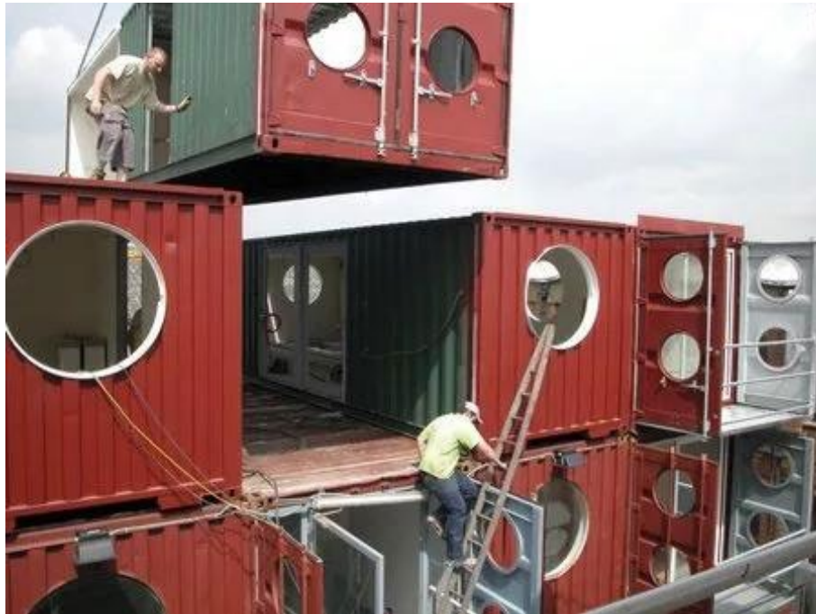
Figura 57: Proceso de construcción Container City
