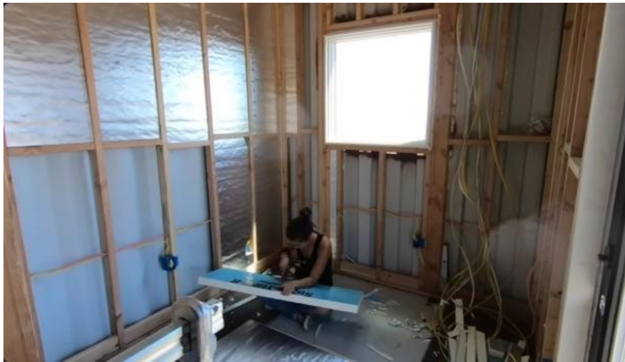
Figura 83: Colocación de aislamiento térmico
