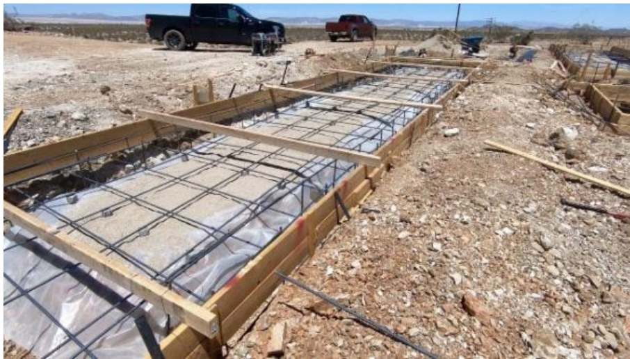
Figura 71: Aislamiento del terreno
