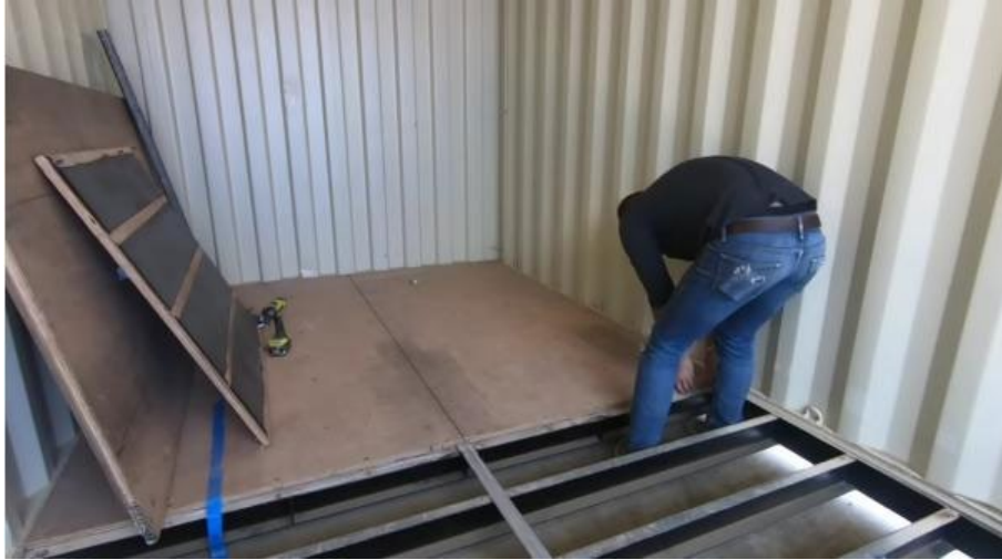
Figura 86: Acondicionamiento de piso
