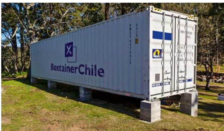
Figura 74: Instalación sobre terreno
