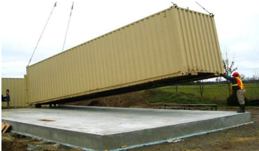
Figura 73: Colocación de contenedor
