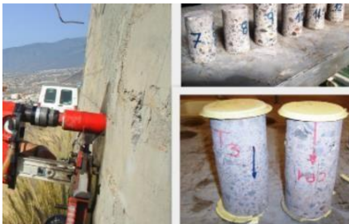
Figura 43. Extracción de testigos.
