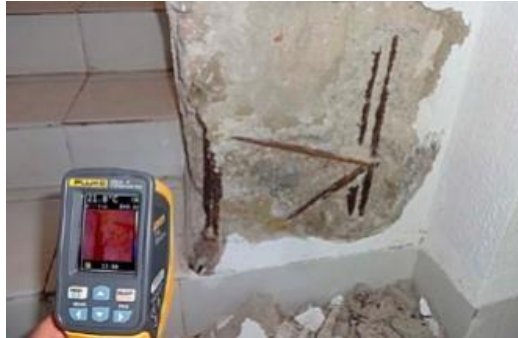
Figura 39. Termografía de infrarrojo
