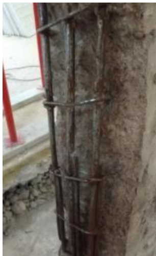
Figura 44. Toma de muestras de armadura
