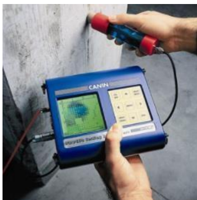
Figura 36. Ensayo de grado de corrosión
