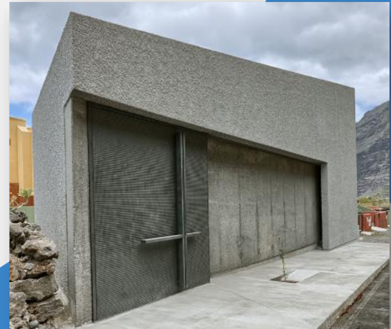
Imagen 37: Texturas de hormigón utilizadas en la capilla.
