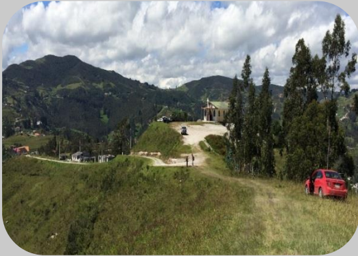
Fotografía 17: Loma de Monjas. Carretero irregular.
