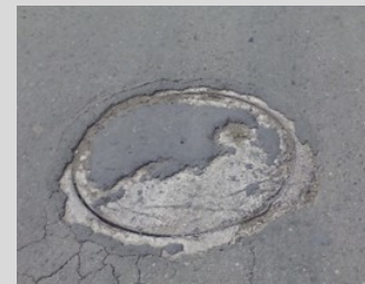
Foto 19. Ejemplo de alcantarillado y recolección aguas servidas.
