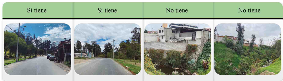
FIGURA 2.50: Levantamiento fotográfico de la accesibilidad de la línea edificada Elaboración: Propia
