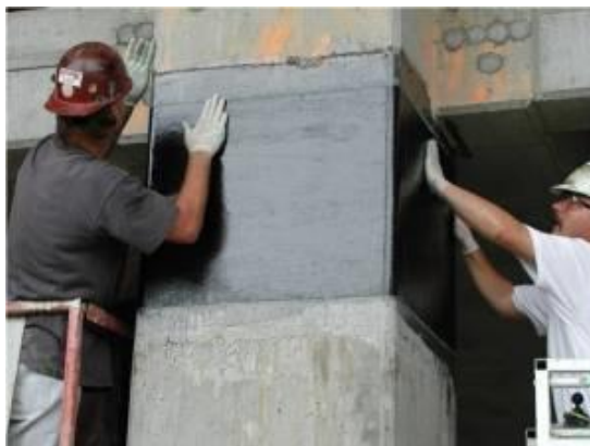
Figura: 69. Aplicación de CFRP en columnas
