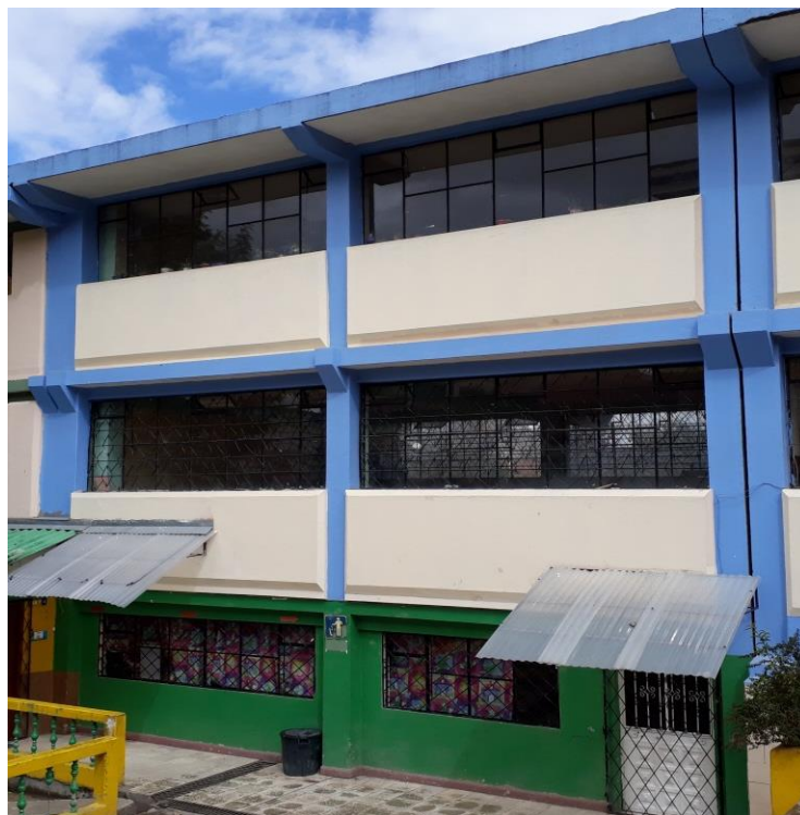
Figura: 5. Elementos estructurales principales del bloque 3 de la Unidad Educativa “Alberto Andrade Arízaga, Brummel”. Fuente: Autor
