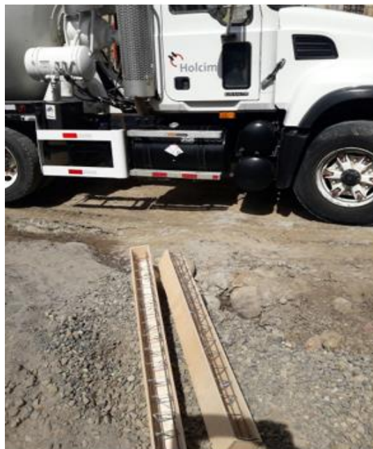
Figura: 74. Hormigonera Holcim lista para vertir hormigón para la fundición de las vigas para el ensayo Fuente: Autor
