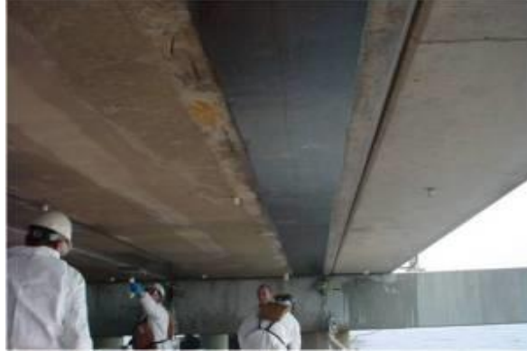
Figura: 72. Aplicación de CFRP en vigas
