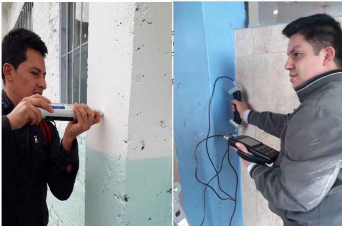
Figura: 20. Medición de la Resistencia del Hormigón en las columnas en la Unidades Educativas Fuente: Autor
