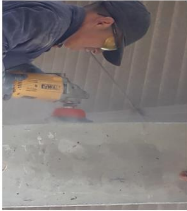
Figura: 77. Preparado de la superficie de la viga a reforzar
