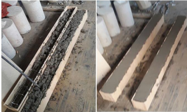
Figura: 75. Encofrado y función de vigas para el ensayo Fuente: Autor
