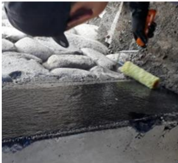
Figura: 79. Aplicación de epoxico SikaDur 300 sobre SikaWrap 600C
