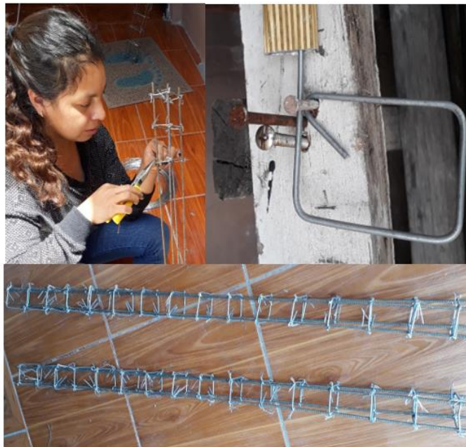
Figura: 73. Armado de Vigas para ensayo Fuente: Autor
