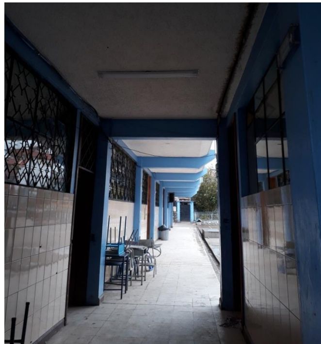
Figura: 14. Junta de dilatación entre bloques de la Unidad Educativa “Alberto Andrade Arízaga, Brummel” Fuente: Autor
