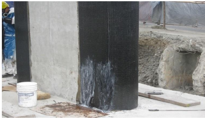
Figura: 71. Aplicaciones de CFRP en muros y albañilería Fuente: (Fibrwrap Peru, s.f.)
