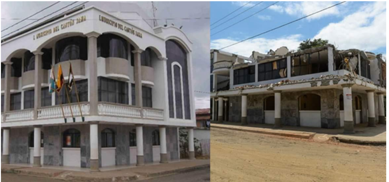
Figura: 27. Colapso de una edificación Fuente: (El Telegrafo, 2016)
