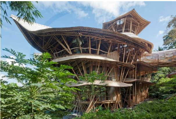
Imagen N° 6. Construcción de Bambú
