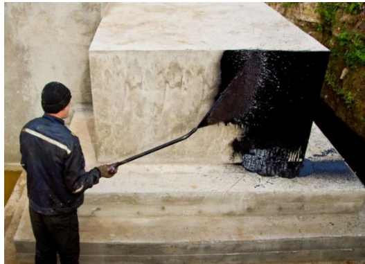
Figura 111: Impermeabilización con pintura asfáltica.
