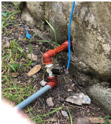
Figura 3.15: Instalación de las válvulas
