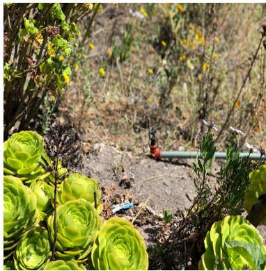
Figura 3.14: Instalación del sistema de cañerías
