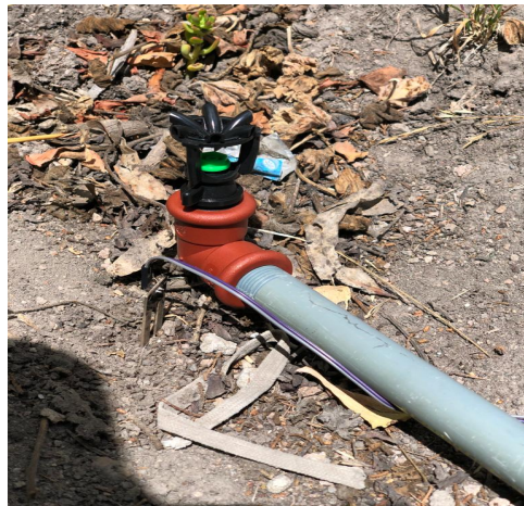
Figura 3.18: Instalación de los sensores en el suelo Fuente: propia
