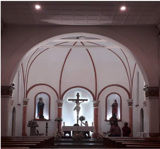
Fig. 27 Iluminación del altar estado actual.
