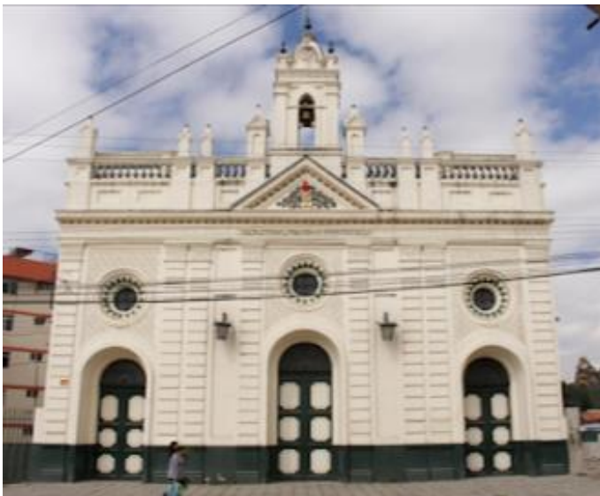
Fig. 23 Edificación fachada frontal.
