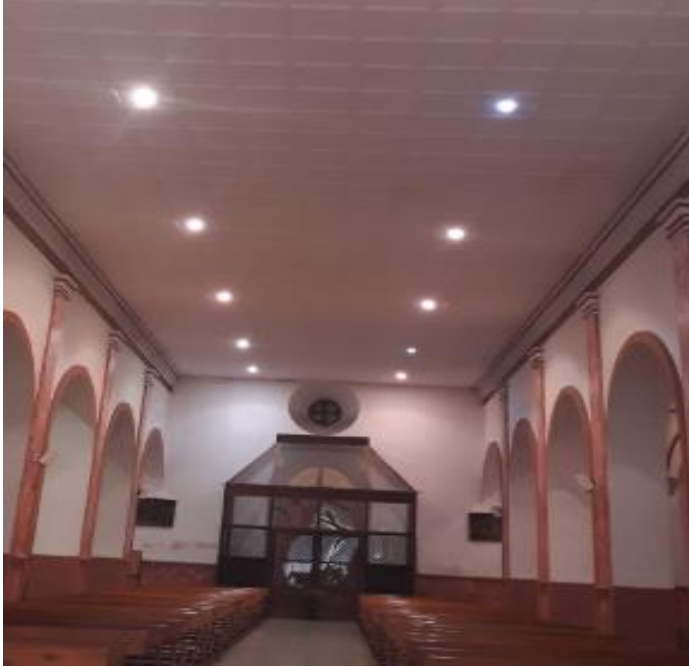
Fig. 22 Área con luminaria de mercurio halogenado.
