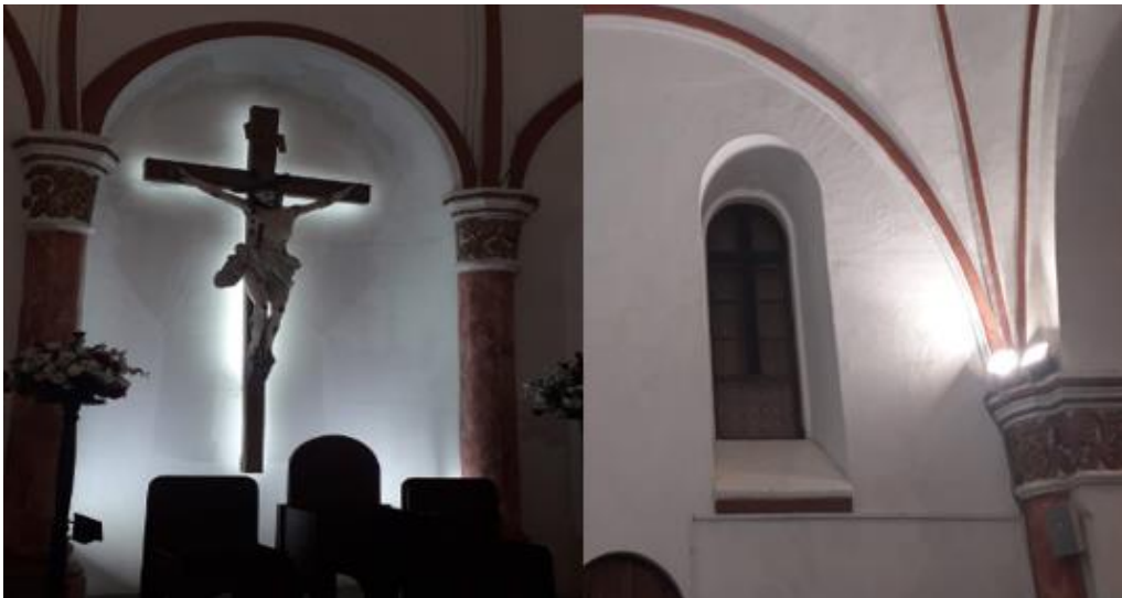
Fig. 23 Montaje de las luminarias
