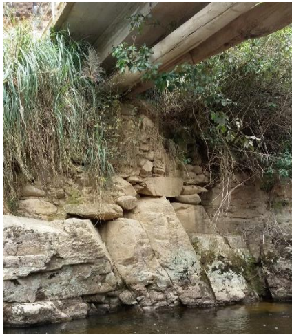
Fig 5: Estado Del Puente
