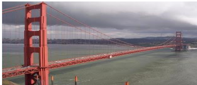
Fig 10: Puente Colgante de San Francisco (California).
