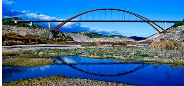
Fig 9: Puente de La Vicaria en Albacete
