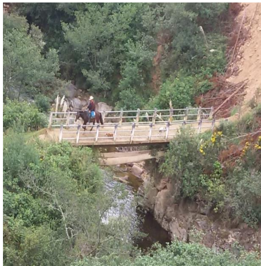
Fig 4: Imagen Del Estado Actual Del Puente
