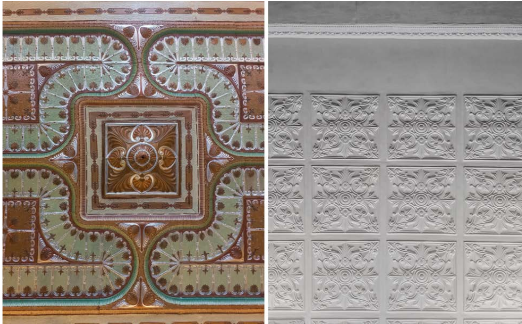
FIGURA 2.25: Botica y Droguería Central, muestra de cielorraso de latón (izquierda). Botica y Droguería Central, muestra de cielorraso de yeso trabajado (derecha). Fuente y elaboración: Autor.
