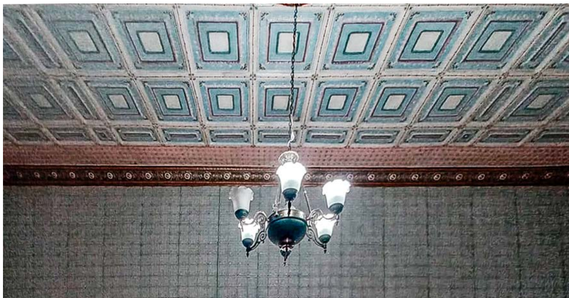
FIGURA 2.3: Casa de las Palomas, cielorraso de latón – Salón Principal. Fuente y elaboración: Autor.
