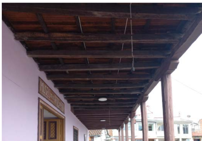
FIGURA 1.13: Casa de Chaguarchimbana, cielorraso colonial de envigado visto. Fuente y elaboración: Autor.
