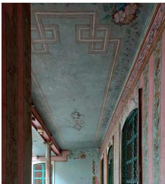
FIGURA 1.15: Casa de las Palomas, cielorraso de yeso simple (pintado con motivos de orden franceses). Fuente y elaboración: Autor.
