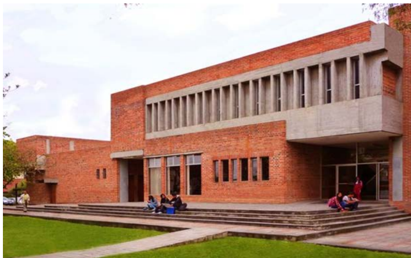
FIGURA 1.9: Facultad de Arquitectura de la Universidad de Cuenca. Fuente y elaboración: Samaniego (2010)
