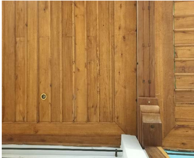
FIGURA 2.20: Museo de los Metales, cielorraso interior (planta baja) perspectiva inferior. Fuente y elaboración: Autor.
