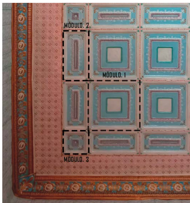
FIGURA 2.5: Casa de las Palomas, módulos de cielorraso de latón – Salón Principal. Fuente y elaboración: Autor.
