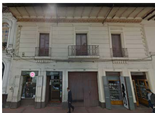
FIGURA 1.12: Edificación Valor arquitectónico B. Fuente: Concejo Municipal de Cuenca, 2010.
