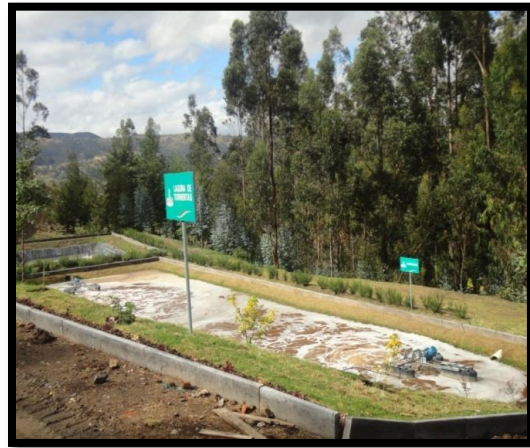
Fotografía No.8. Planta de tratamiento de lixiviados en el relleno sanitario de la ciudad.
