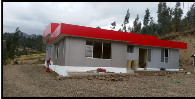
Fotografía No. 9. Planta de esterilización de residuos biopeligrosos
