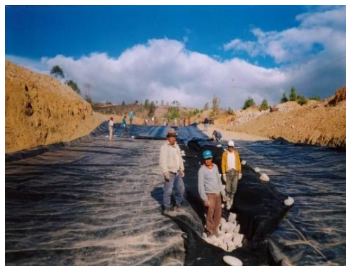
Fotografías 10 y 11: Conformación e impermeabilización del suelo de soporte y construcción de drenes de recolección de lixiviados
