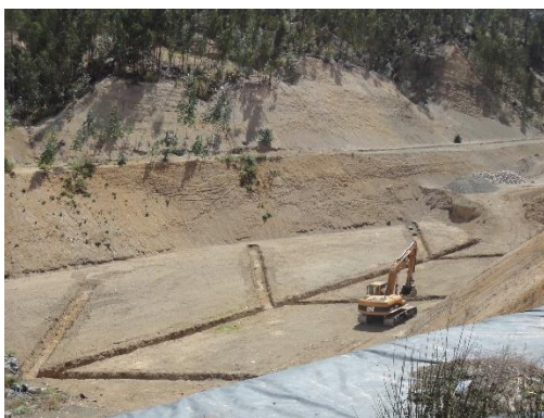
Fotografías 10 y 11: Conformación e impermeabilización del suelo de soporte y construcción de drenes de recolección de lixiviados
