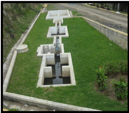
Fotografía No.8. Planta de tratamiento de lixiviados en el relleno sanitario de la ciudad.
