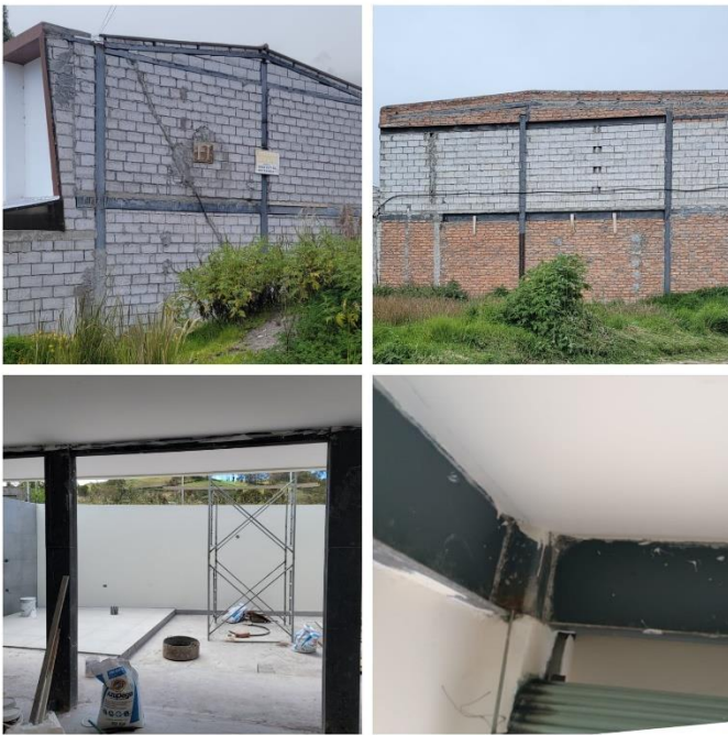
Fig. 9 Sistema estructural acero S5.
