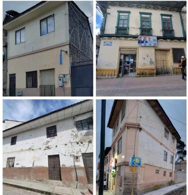
Fig. 6 Sistema estructural mampostería sin refuerzo UMR.
