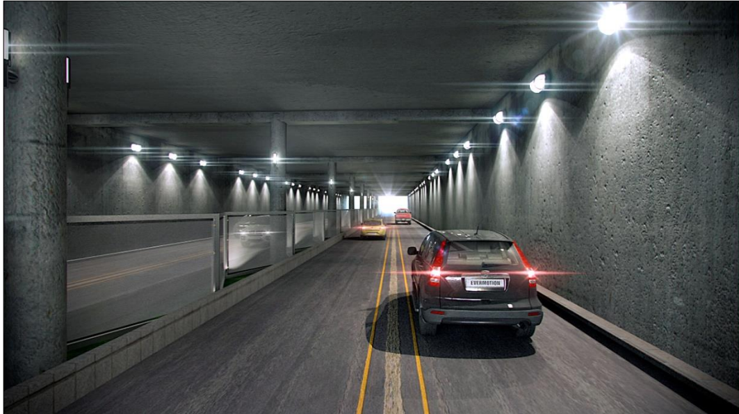
Fig. 87: Vista del interior del Paso Deprimido, Carolina Chérrez.
