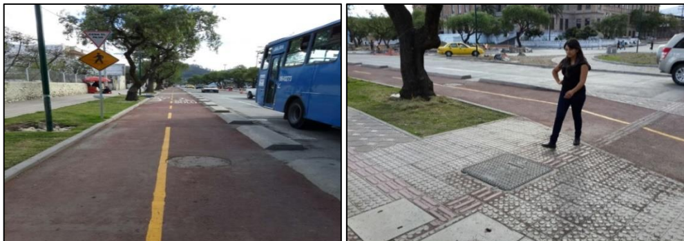
Fig. 63: Izq. Ciclo vía bidireccional ya creada en el lado Noreste de la Avenida Solano de 3 m. de sección, Fig. 64: Der. Diferentes texturas que llevan los pisos de hormigón para facilitar la circulación de personas no videntes. Carolina Chérrez.
