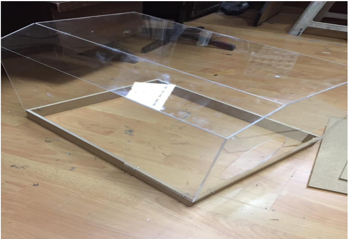
Fotografía 13: Construcción de la caja de acrílico
