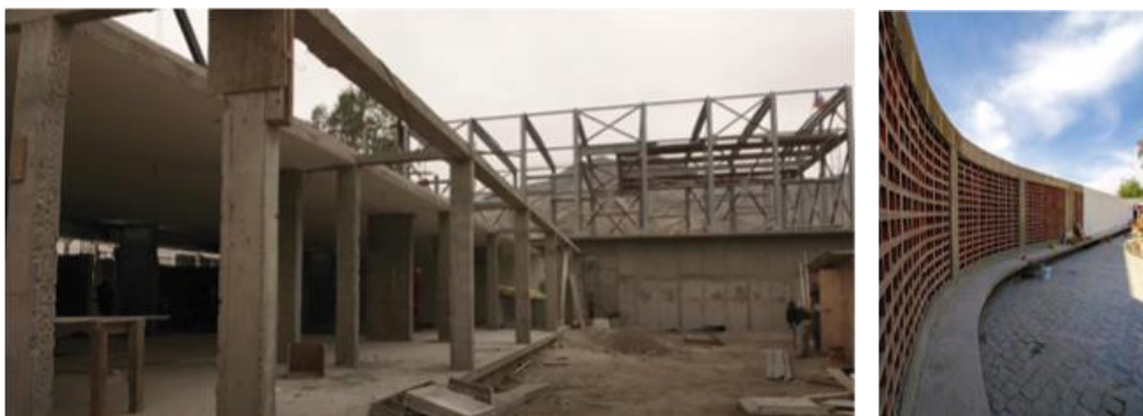
Figura 40: Fase de construcción del Centro Cultural de Lampa.
