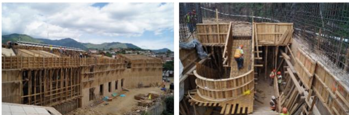
Figura 52: Construcción del CCCTV.
