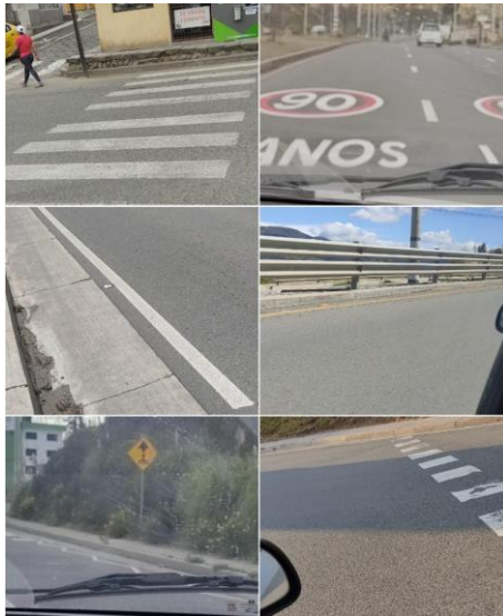
Figura 31: Señales horizontales Elaborado por: Autores
